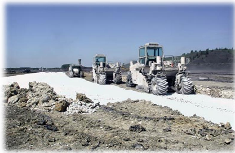
Figure 1.25 Traitement de sol par épandage de chaux (Photo razel)
