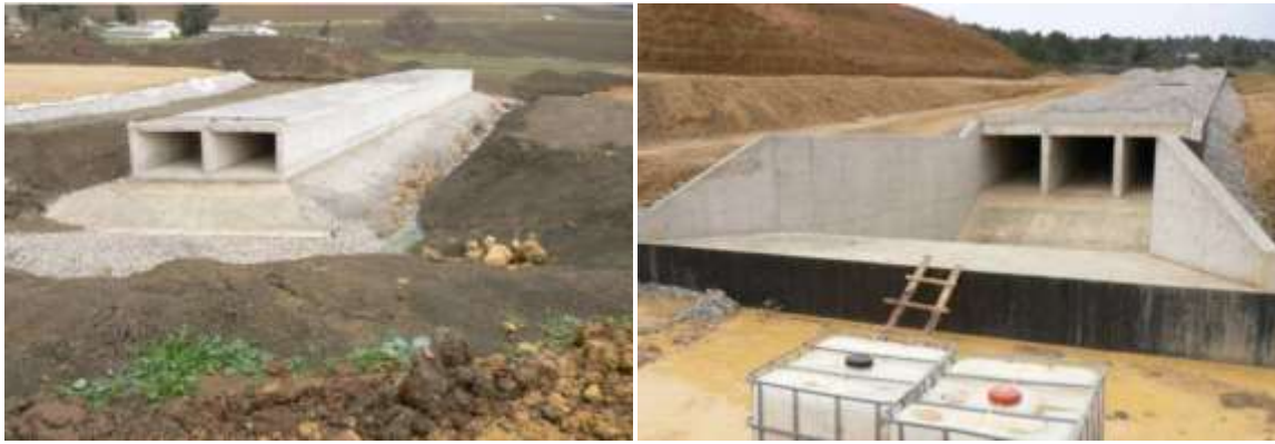
Figure 29 : Exemples des dalots en phase de façonnage
