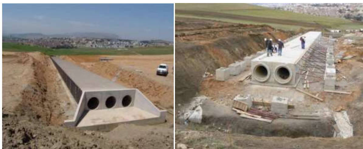
Figure28 : Exemples des buses en phase de façonnage
