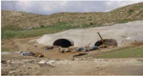
Figure 37 : Portails nord T3 tubes droit et gauche
