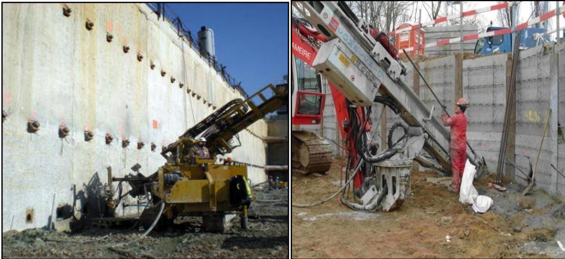
Figure 1.40 Exemple de mur renforcé par ancrage
