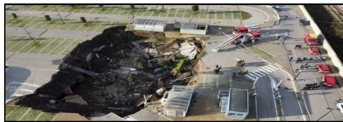
Figure 1.1 Effondrement à Naples (Italie)
