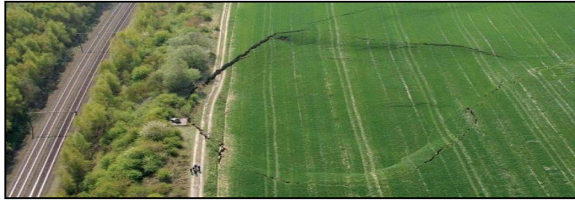
Figure 1.7 Affaissement de terrain
