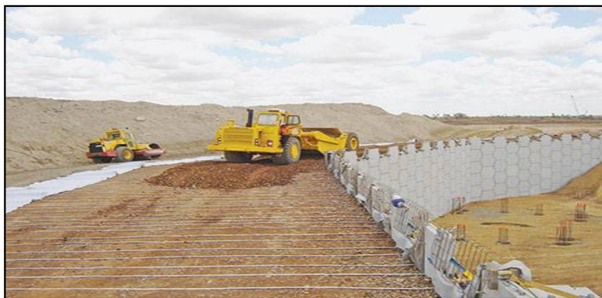
Figure 1.36 Mur en terre armé
