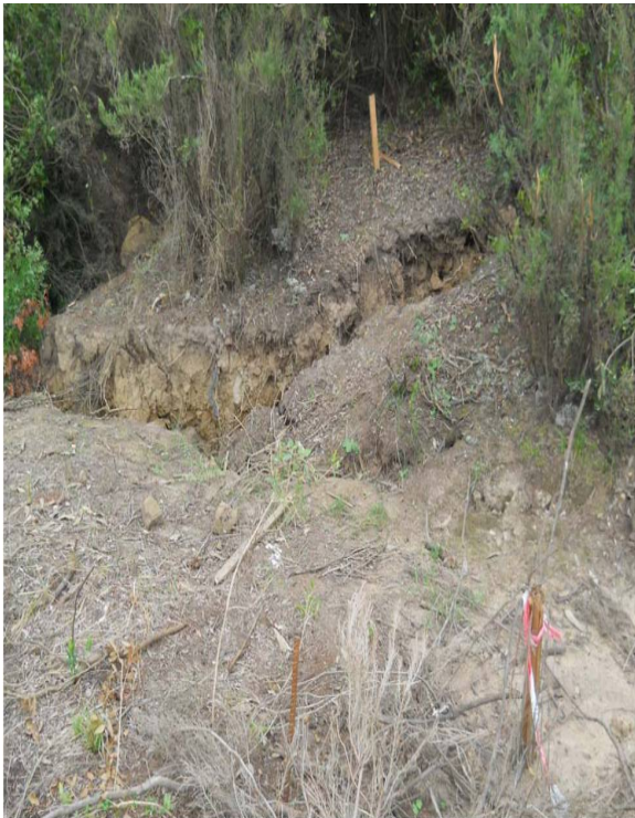
Photos 3.3 État d'apparition des fissures de traction
