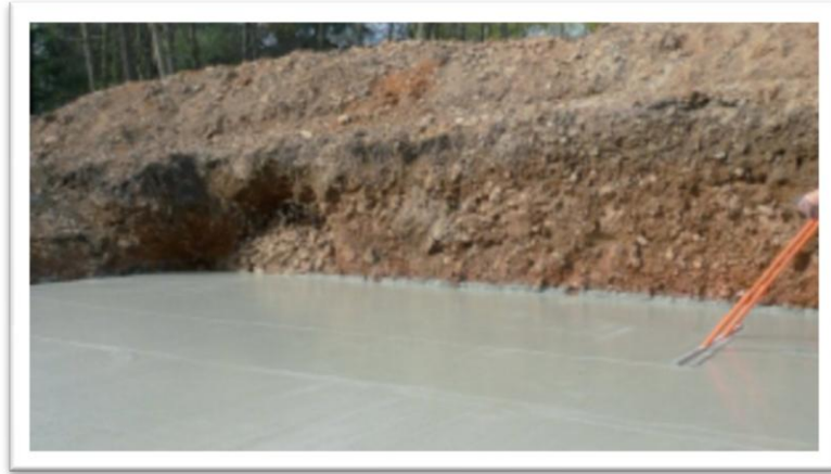
Figure 1.19 : Béton autoplaçant pour la réalisation des dallages sur terre-plein [63]
