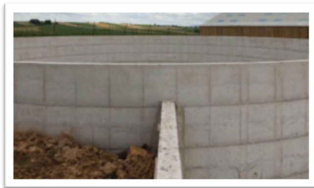
Figure1.23 : Béton autoplaçant pour ouvrages en milieux agressifs [63]
