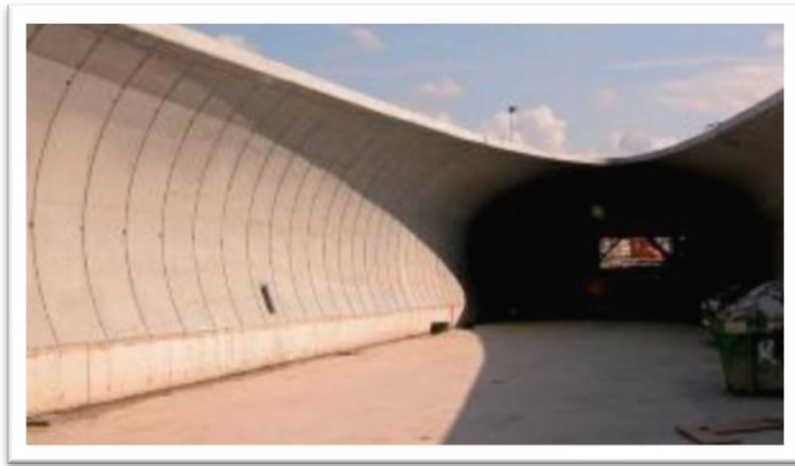
Figure1.17 : Béton autoplaçant pour la réalisation d'ouvrages techniquement complexes [63]
