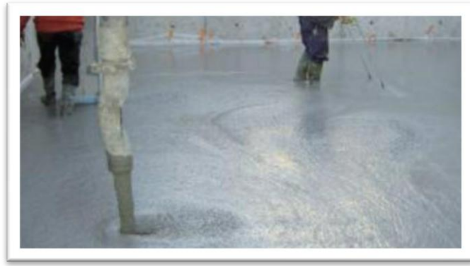
Figure1.22 : Béton autoplaçant pour la réalisation de plancher en dalles pleines ou dalles de compression sur poutrelles-hourdis[63]
