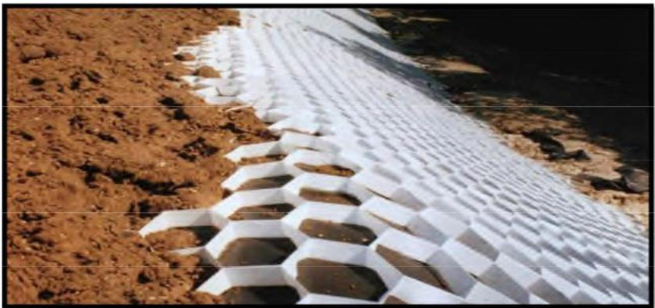
**Figure I.31 - Renforcement par géotextiles (Boulfoul K.,2005)**
