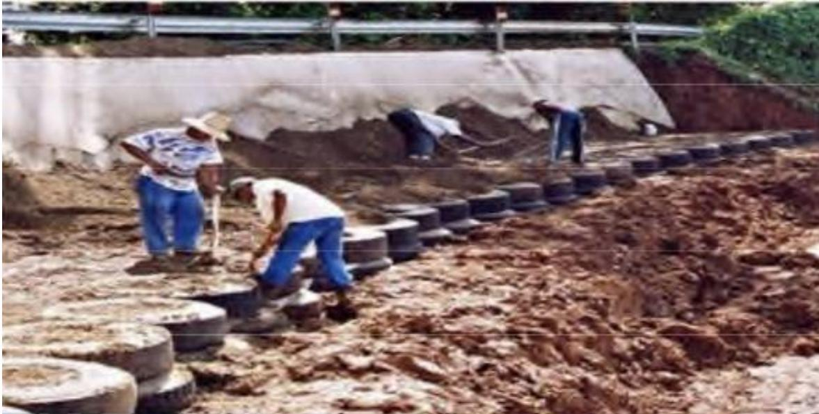
**Figure I.33 - Renforcement par Pneusol. (Bedr S.,2008)**
