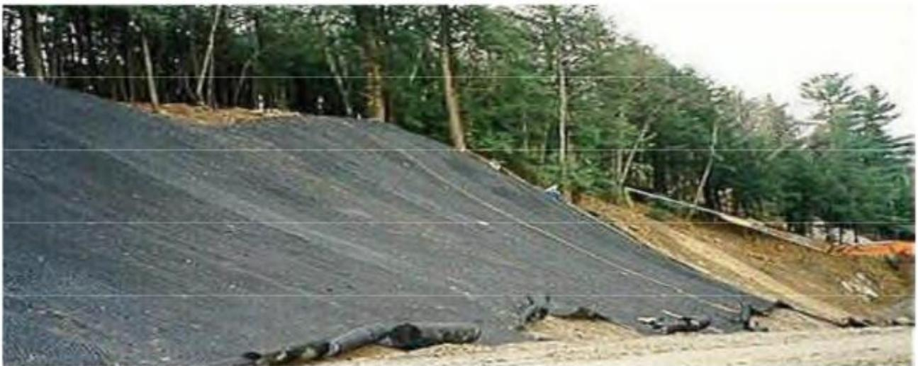
**Figure I.32 - Renforcement par géogrilles.(Boulfoul K.,2005)**
