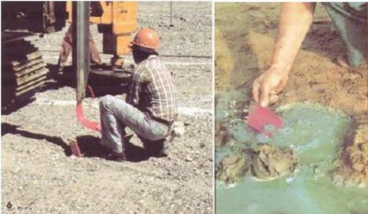
Figure 1.115 : Mise en place et fonctionnement du drain
