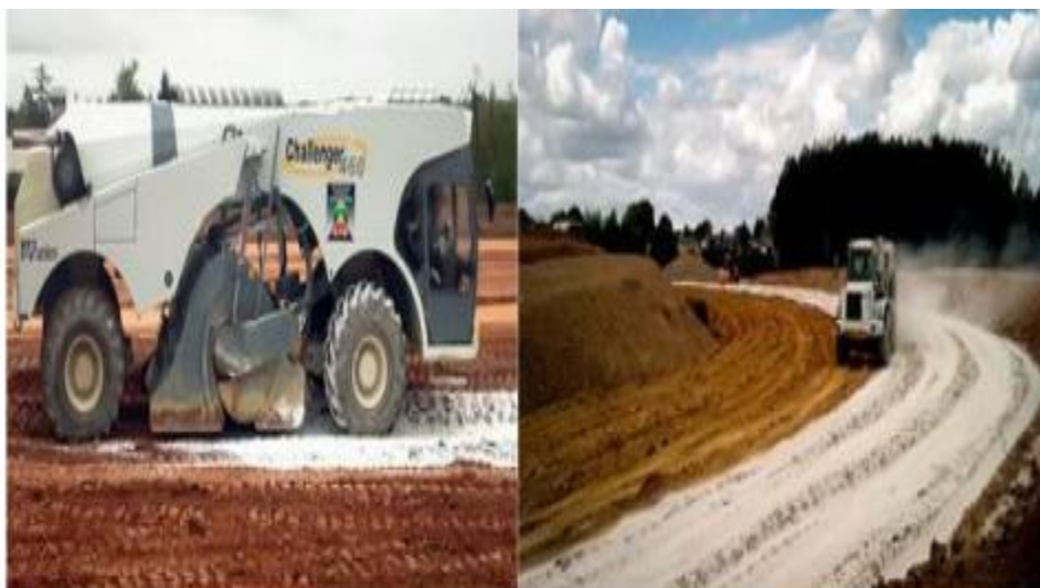
Figure 1.19 : Chantier de traitement du sol à la chaux.
