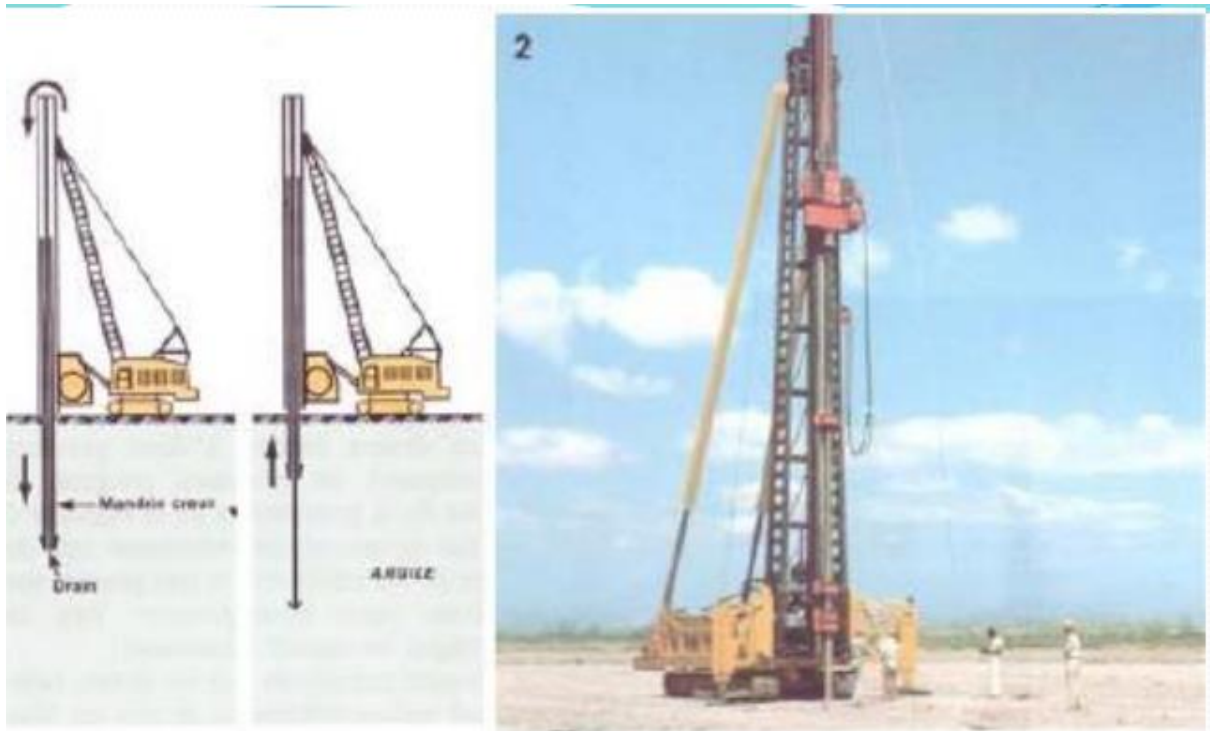
Figure 1.14 : Mise en place et fonctionnement du drain
