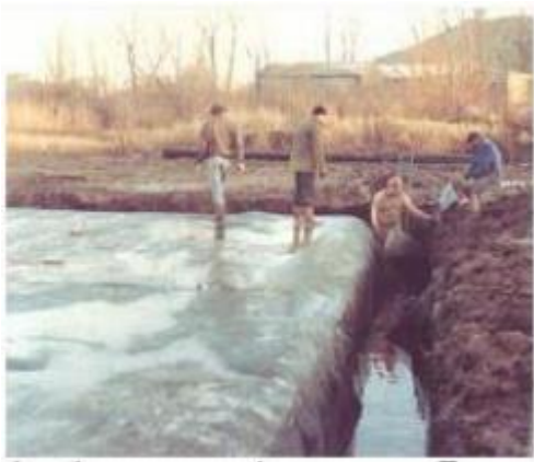
Figure 1.10 : Etanchéité périphérique vue d'un chantier en cours de pompage
