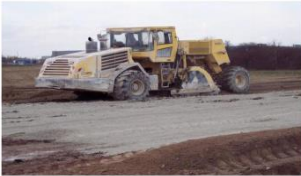
Figure 1.20 : Chantier de traitement du sol au ciment.
