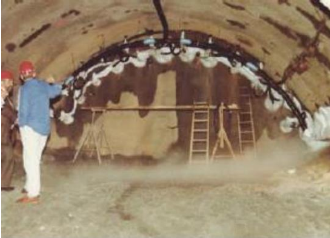
Figure 1.18 : Traitement par congélation à Vienne sous bâtiment pour tunnel de métro
