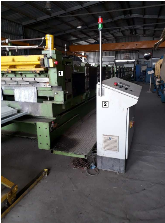
Figure I.14. Emplacement du moteur électrique
