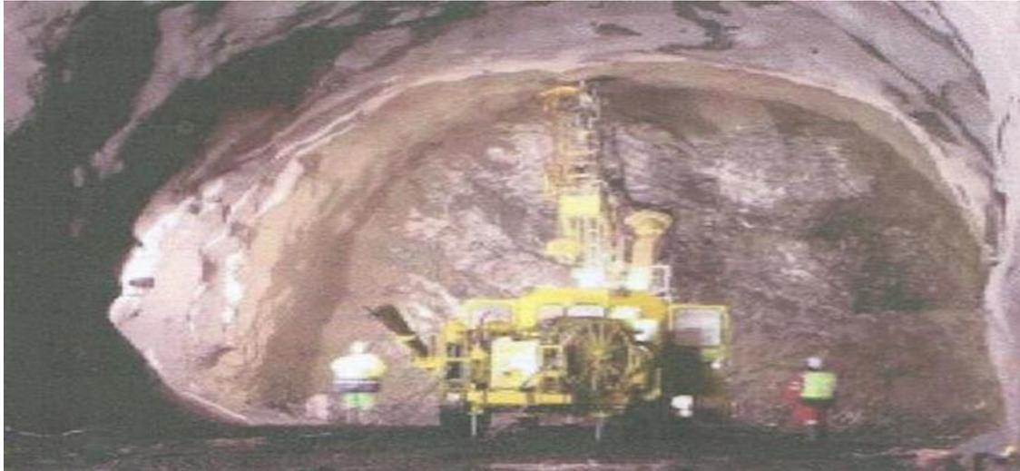
**Figure I.8 : Creusement a plain section.**
