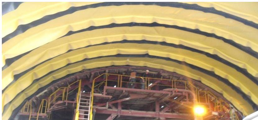
**Figure I.20: Mise en place du dispositif d'étanchéité.**
