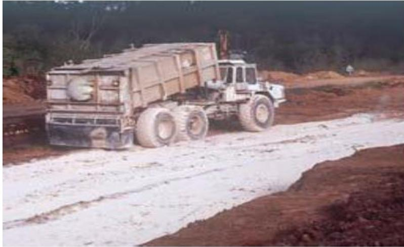
**Figure 2.7.** Epannage du la chaux.
