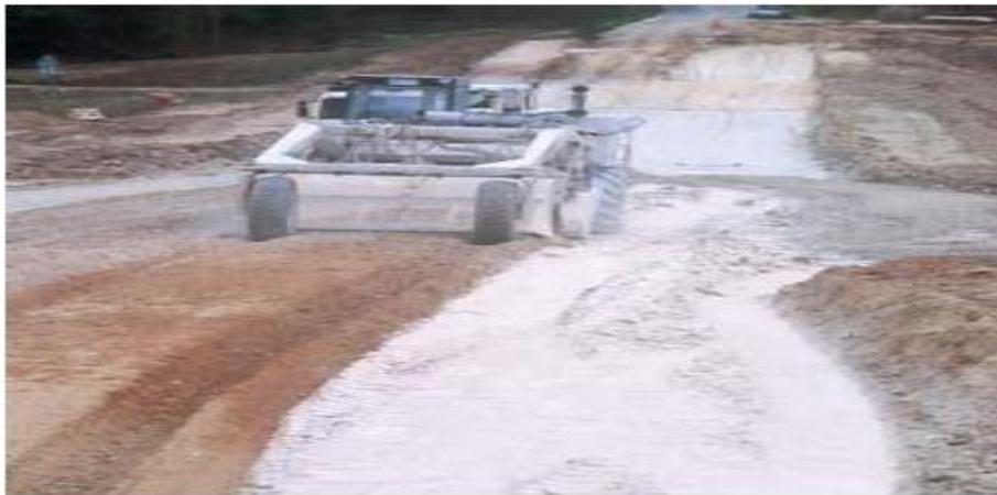
**Figure 2.8.** Malaxage de la chaux sur chantier.
