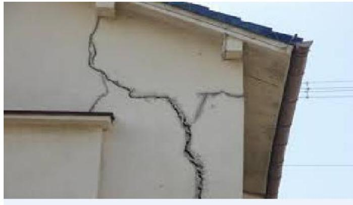
**Figure 1.8.** fissures au niveau d'une structure de génie civil.
