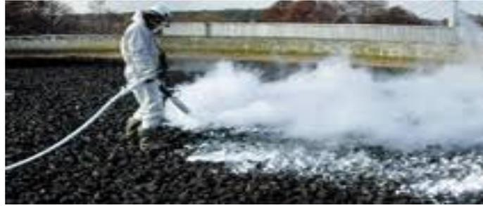
**Figure 1.14.** Chantier utilisant la congélation du sol.
