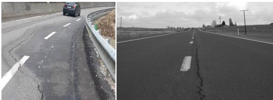
**Figure 1.9.** Déformation d'une chaussée de sol instable.
