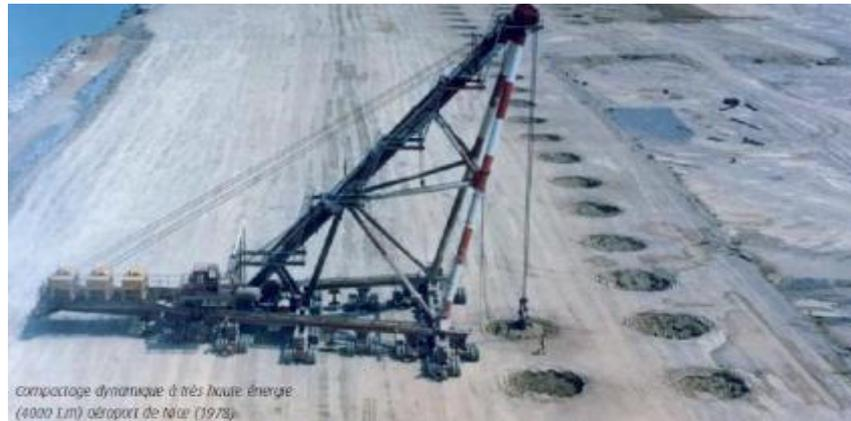
**Figure 1.10** .Chantier d'un compactage dynamique profond.
