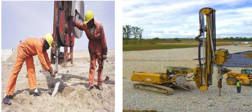
**Figure 1.13.** Installation des drains.
