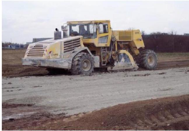
**Figure 1.16.** Chantier de traitement du sol au ciment.
