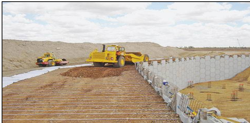
Figure 1.36 Mur en terre armé
