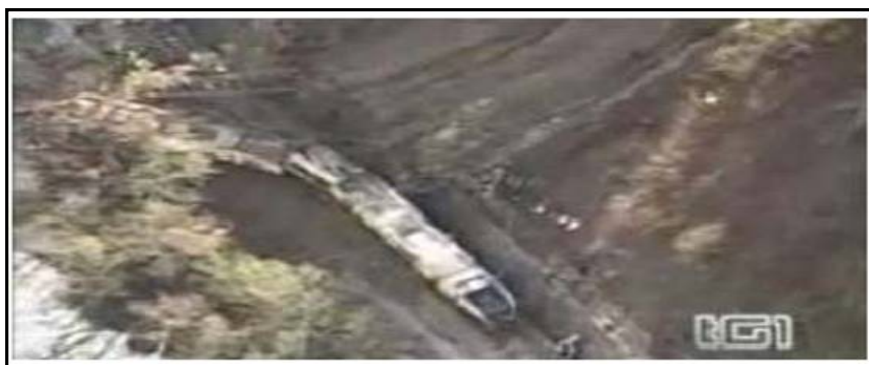
Figure 1.19 Glissement de terrain causé par une explosion (Italie)
