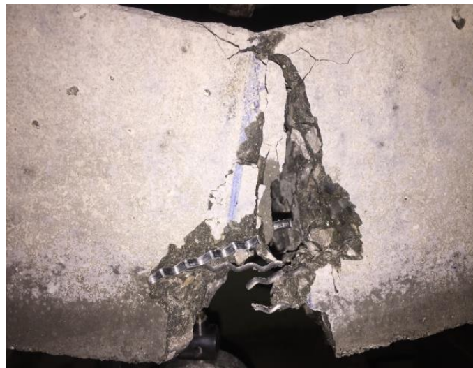
Figure III.14 Mode de rupture de l'éprouvette en béton avec fibres ondulées
