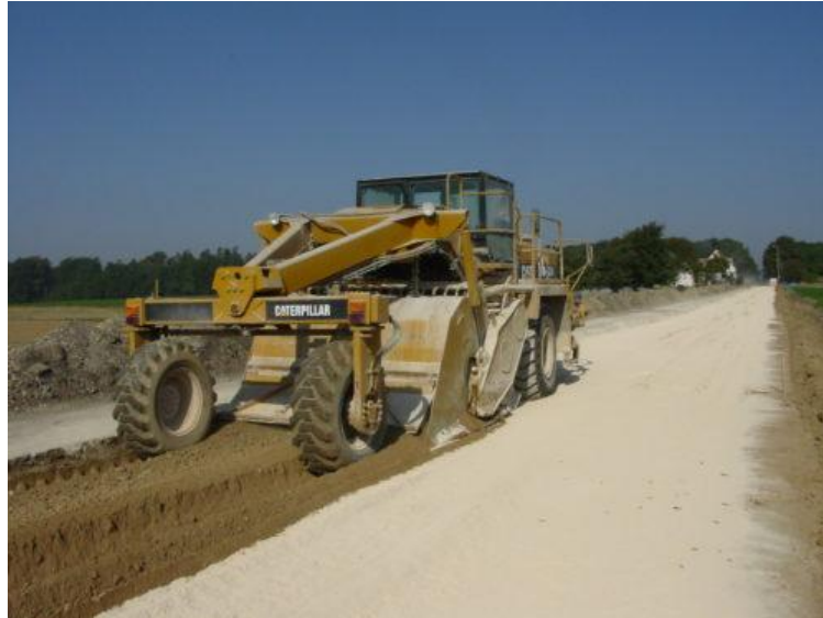
Figure I.15 : Traitement des sols
