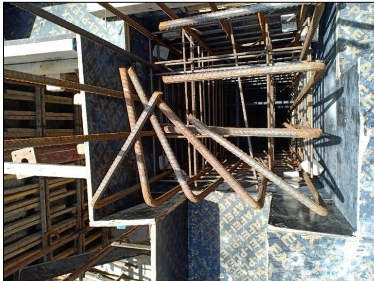
Figure45: Reduction de la section de poteau sur chantier.
