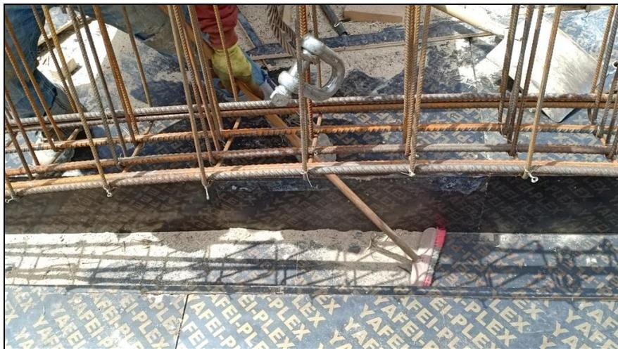
Figure71 :Nettoyage du coffrage
