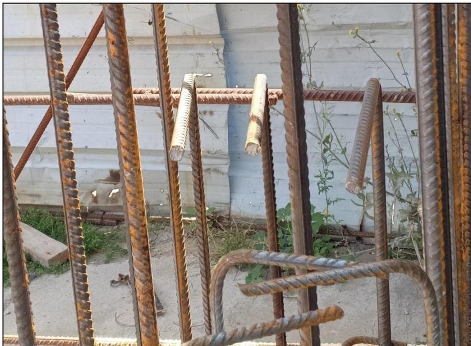
Figure84 : Armatures coudée à l'extrémité
