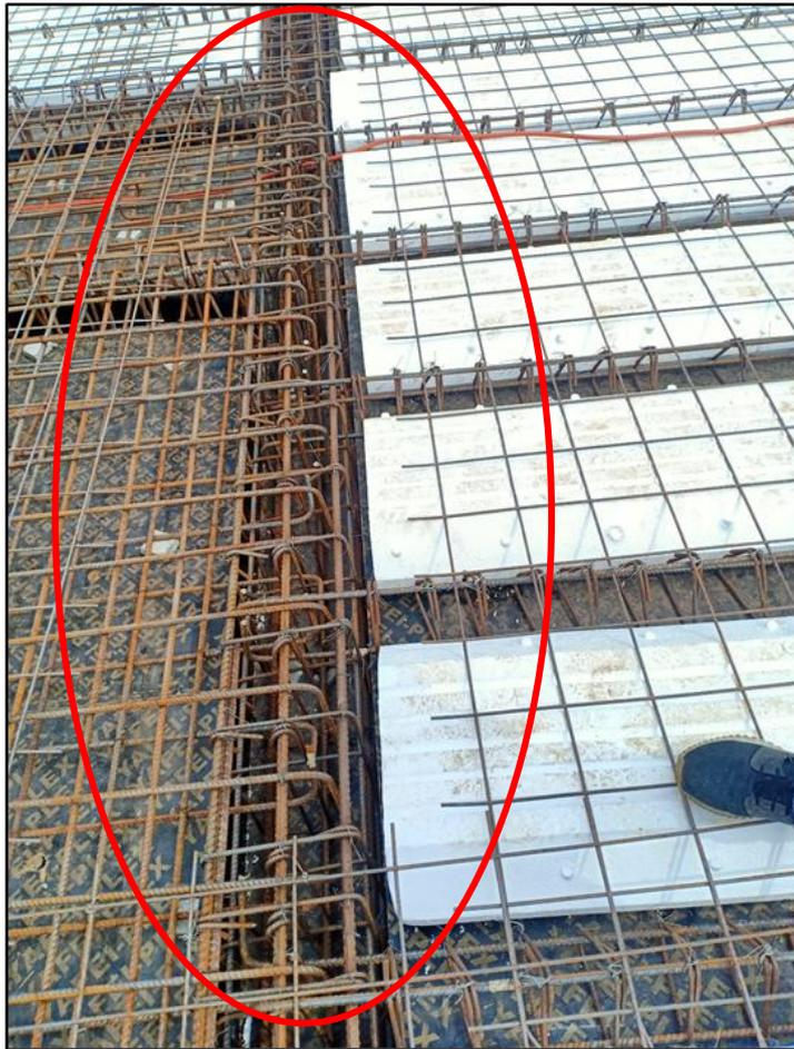
Figure 83: manque des bandes de treillis soudé
