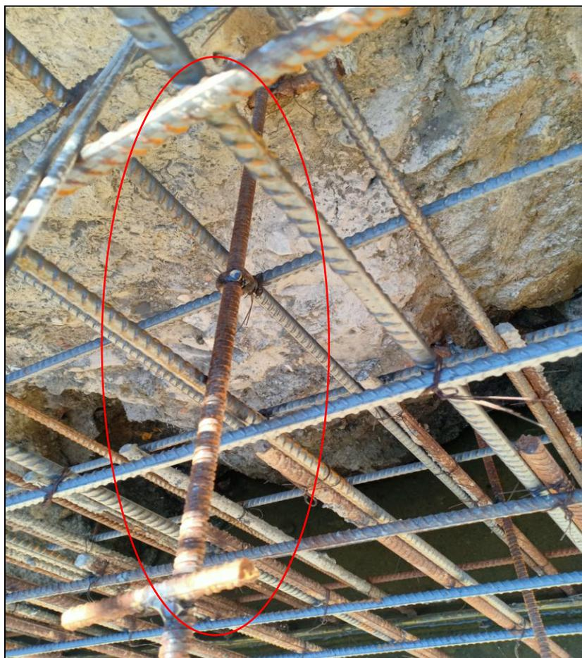
Figure 50 : Mise en place des tiges filtrées dans le voile périphérique
