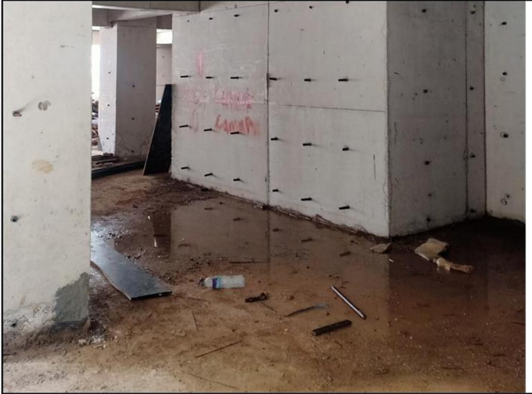
Figure87 : infiltration d'eau dans le sous-sol
