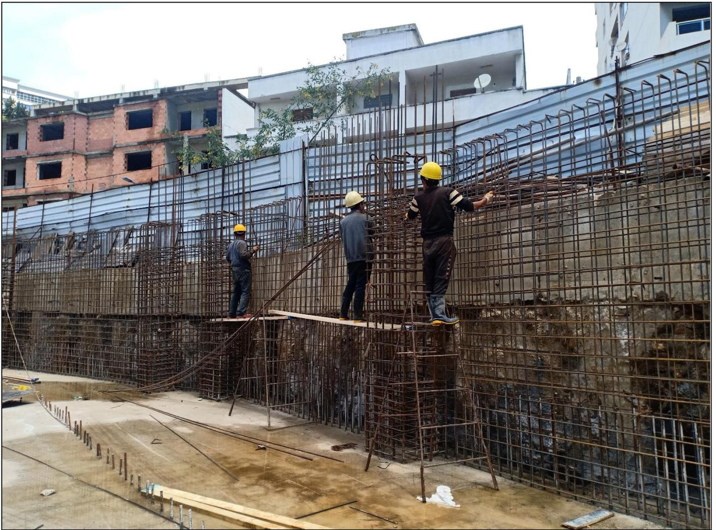
Figure49 : Ferrailage de voile périphérique
