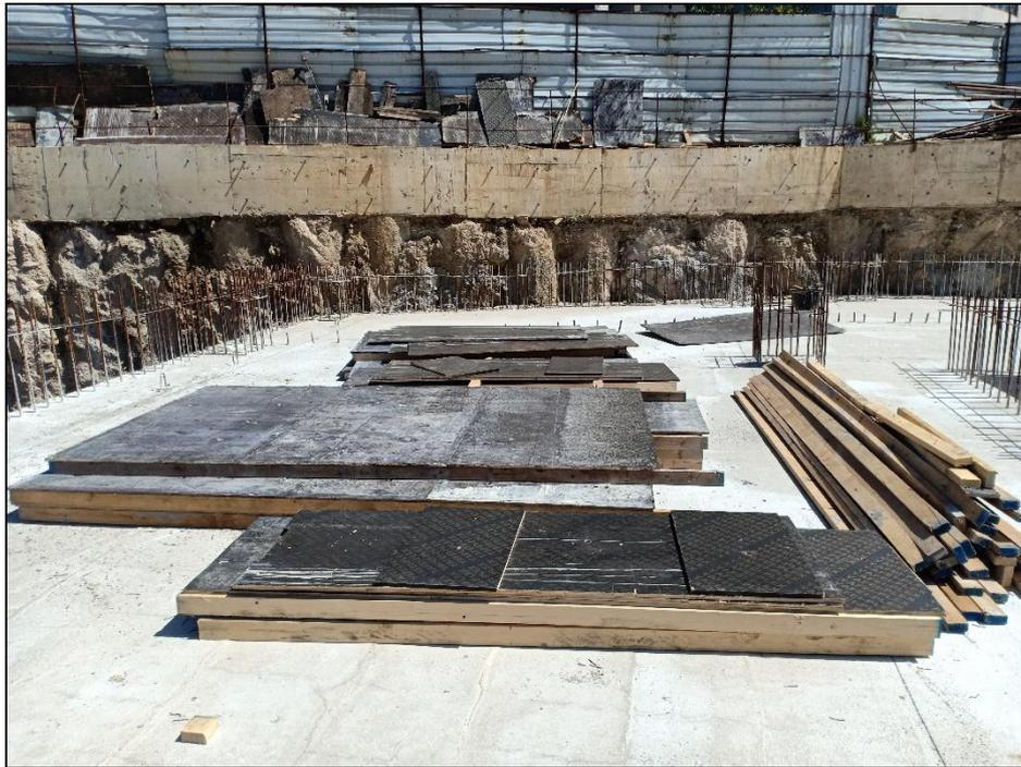
Figure 51 : 'Coffrage à parement fin'
