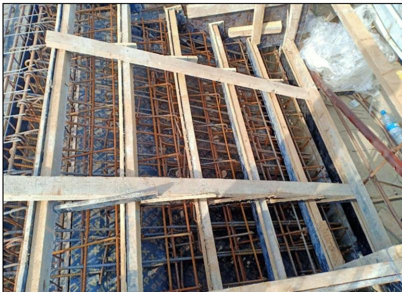
Figure68: Ferrailage et coffrage des escaliers
