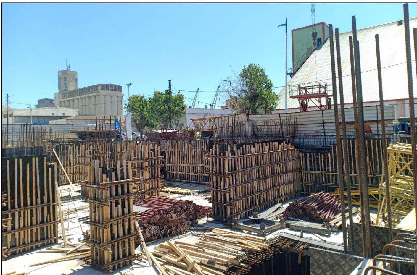
Figure 55: Fin de la phase de coffrage des éléments verticaux
