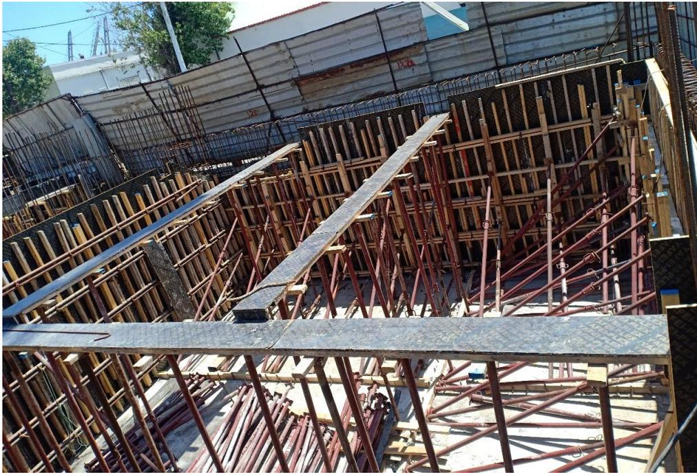
Figure56: emplacement fond de coffrage
