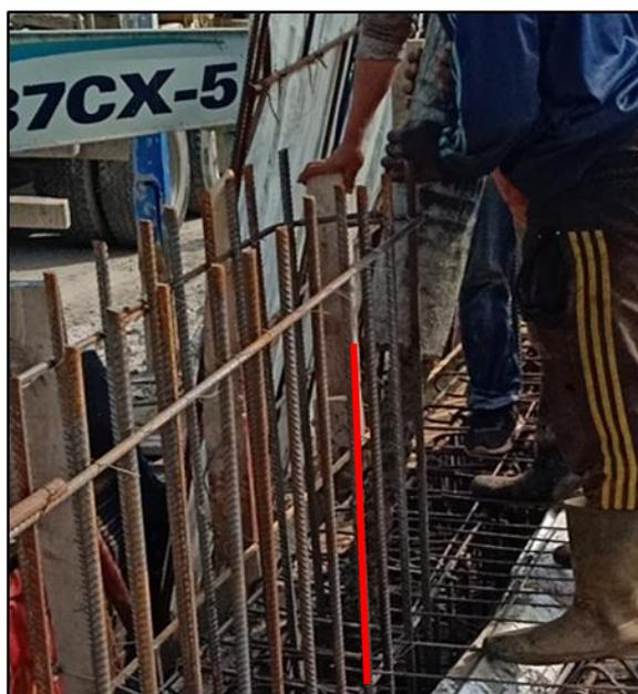
Figure74 : Hauteur de coulage du beton
