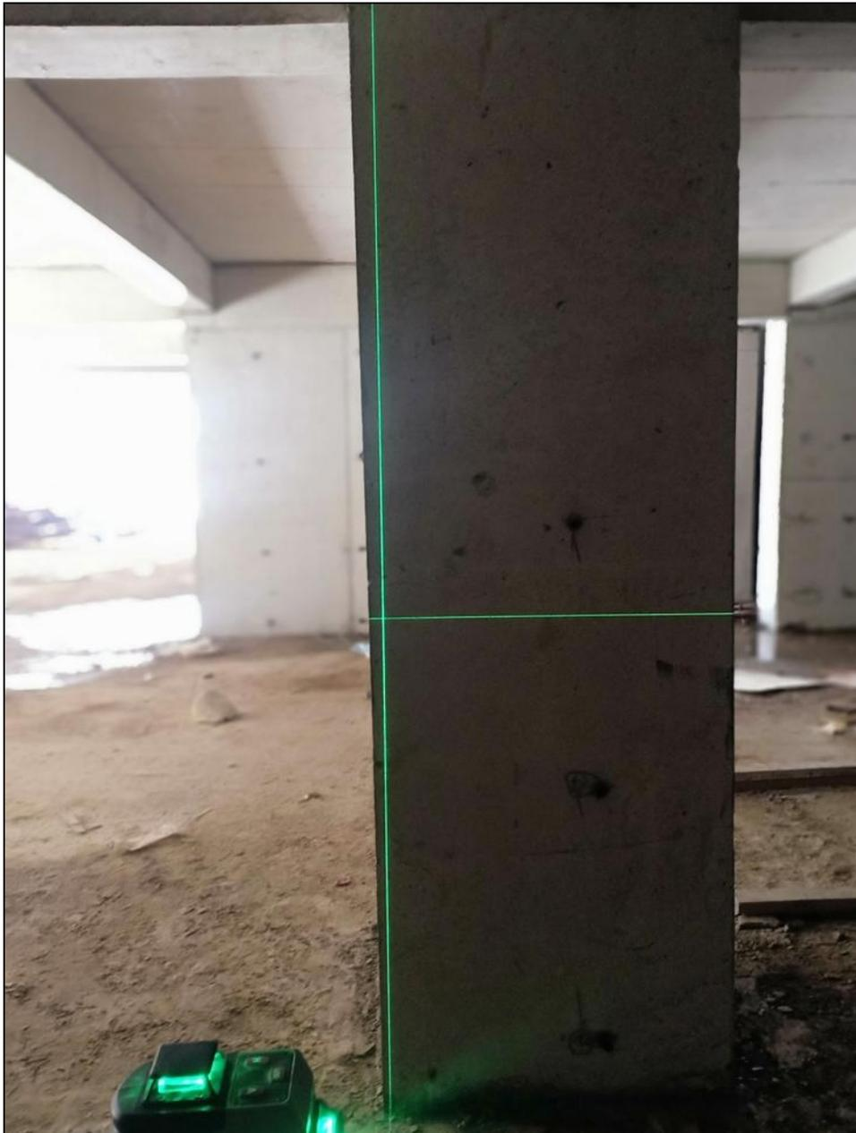
Figure77: Verification de la verticalité d'un poteau avec un niveau laser
