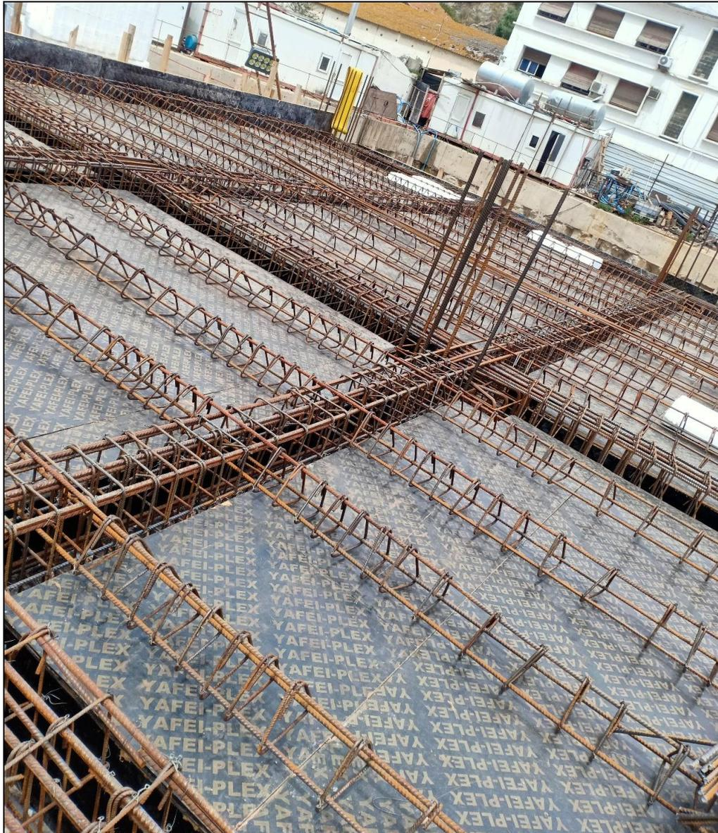
Figure61:Coffrage des poutrelles
