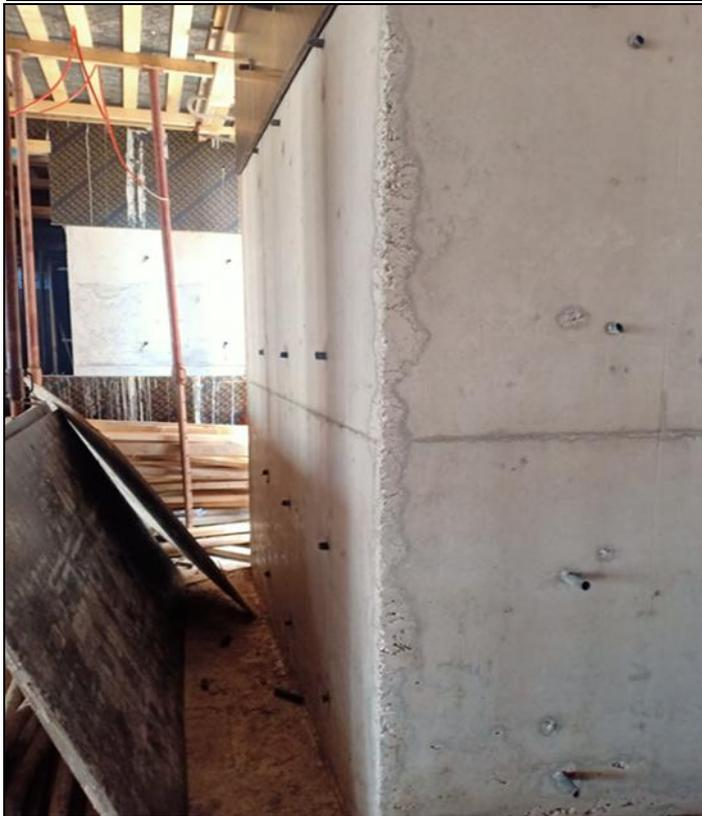
Figure76: Décoffrage des éléments verticaux(poteau et voile)
