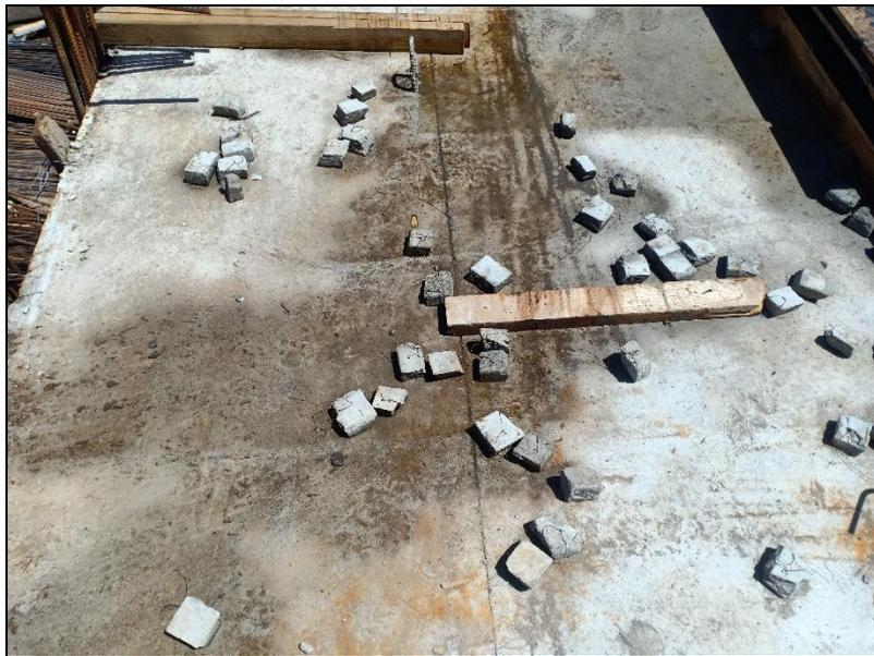
Figure47: Les cales à béton utilisé sur chantier.
