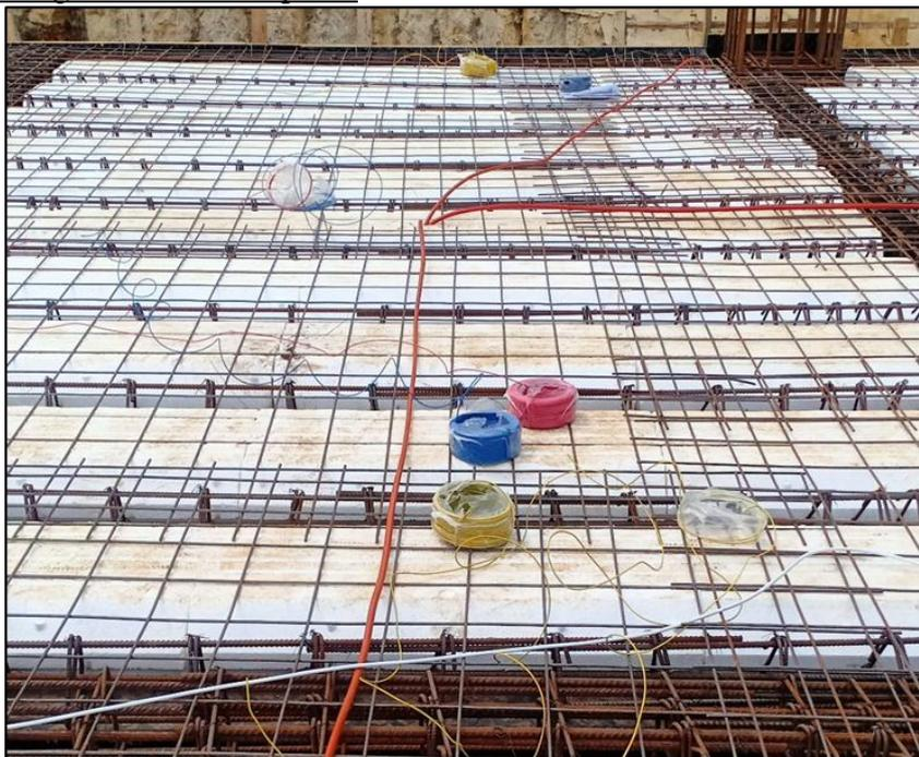
Figure 72: Les gaines d'électricité
