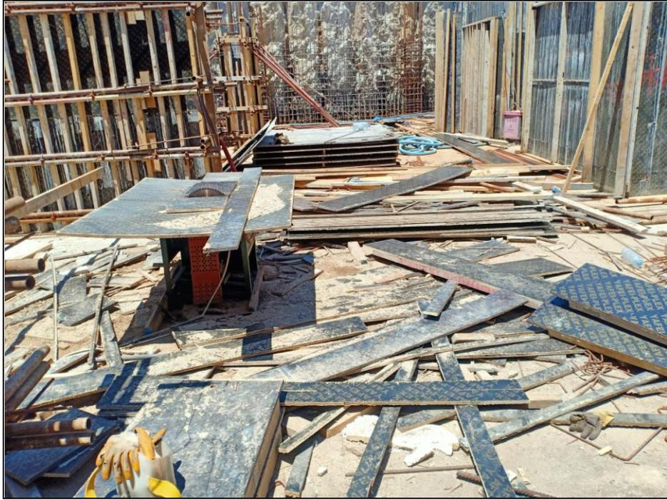
Figure 24 : Poste de fabrication du coffrage
