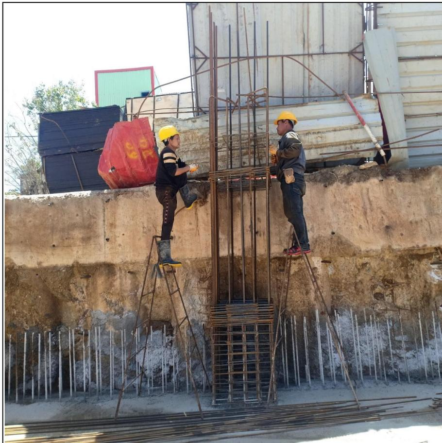
Figure43: Disposition des cadres dans le poteau
