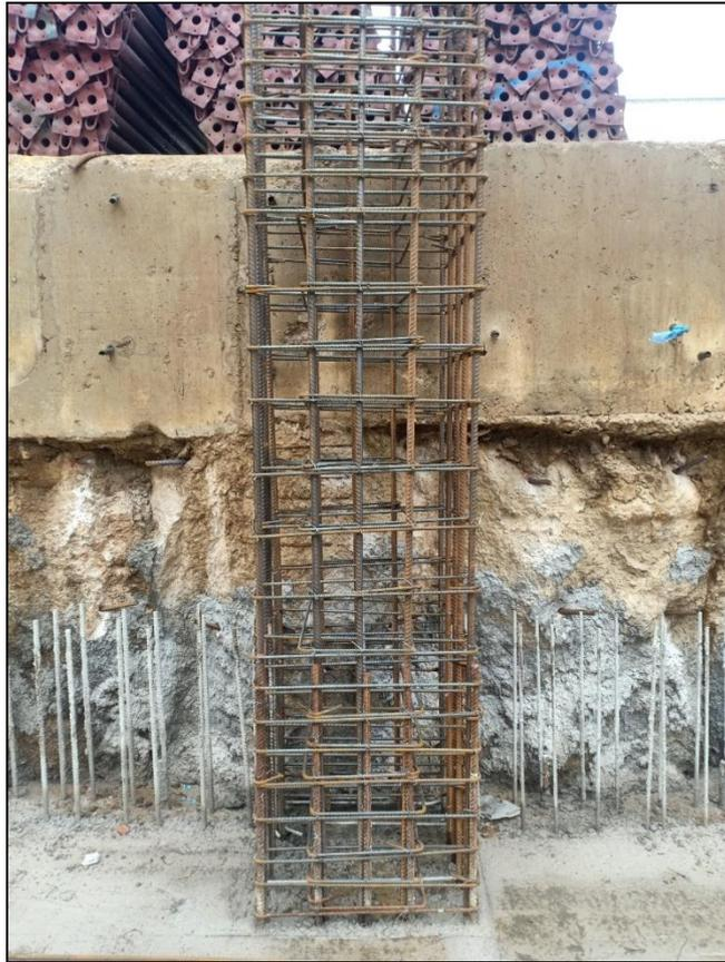
Figure42 : Ferrailage d'un poteau
