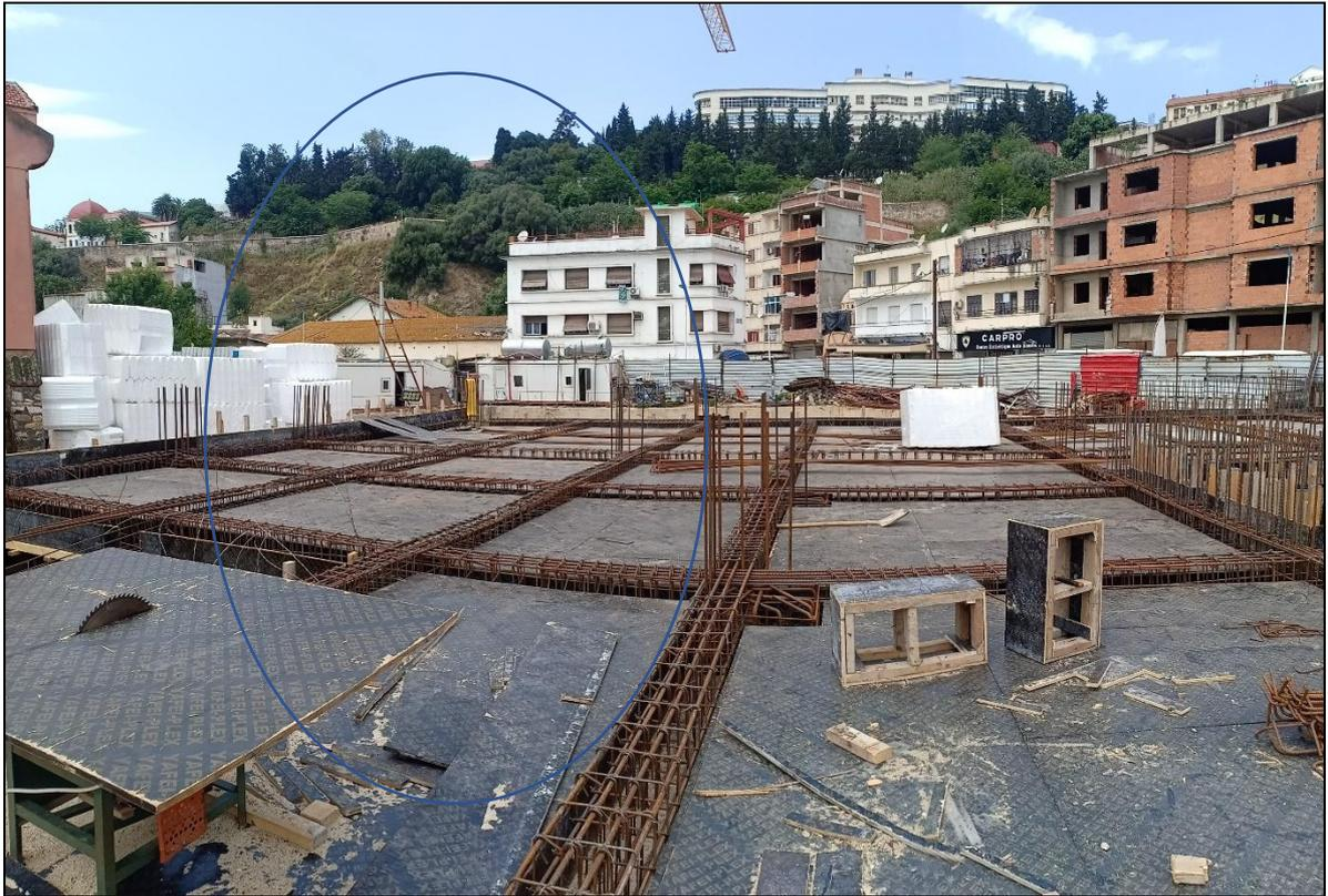
Figure58:Le système a poutre croisée
