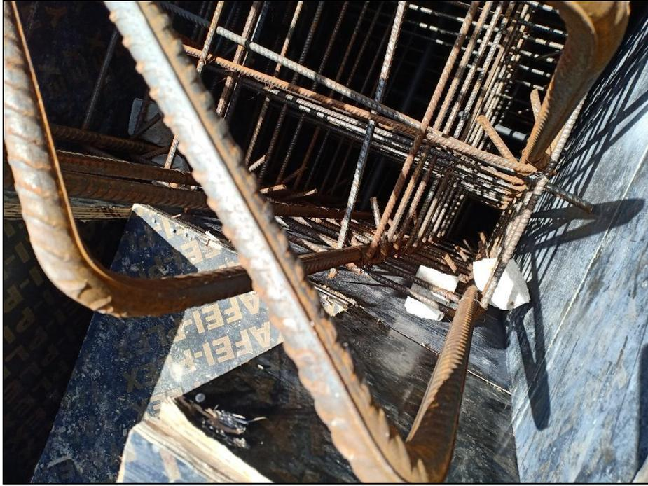
Figure46: Mise en place des cales a béton
