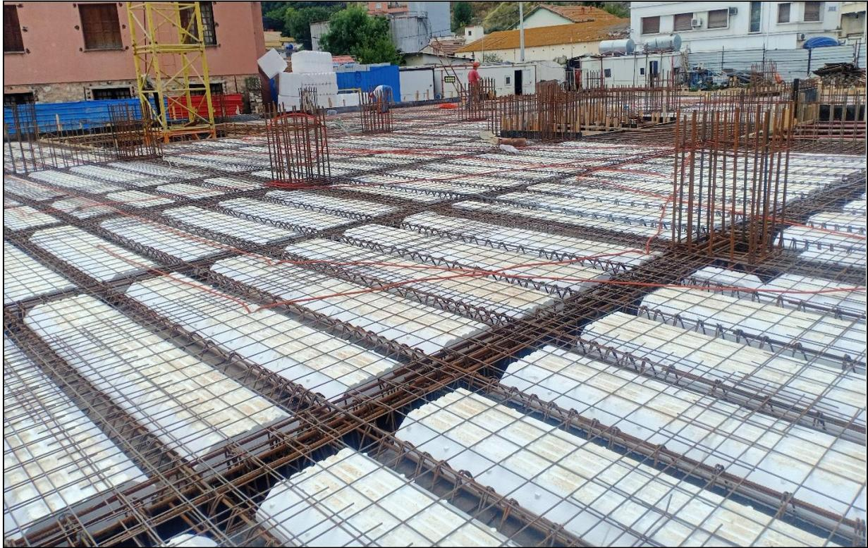
Figure63: La mise en place des treillis soudés
