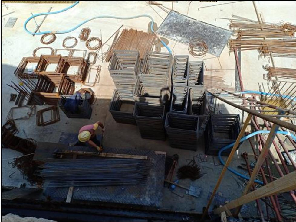
Figure 23 : Le Poste de Ferrailage
