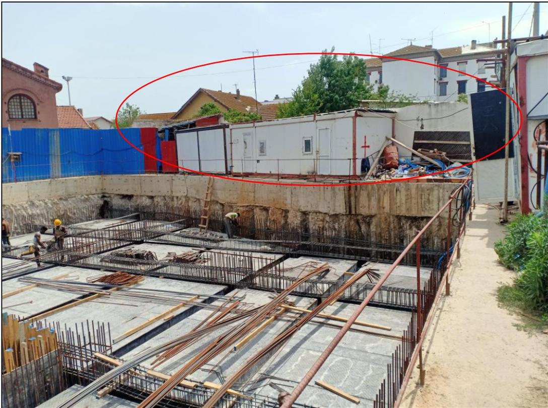
Figure 25 : Les locaux de chantier
