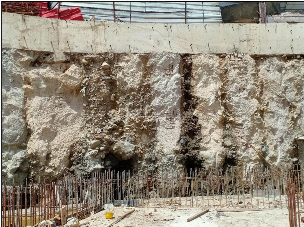
Figure29: La paroi des pieux sécants avec poutre de couronnement
