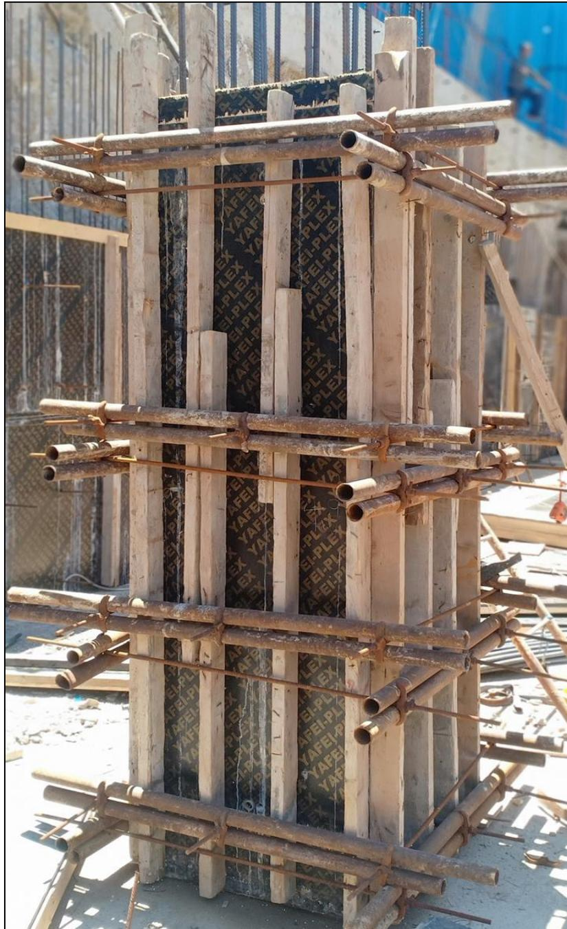
Figure52 : Coffrage des poteaux
