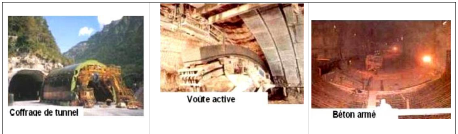
Figure I.19: Quelques types de revêtement définitif.
