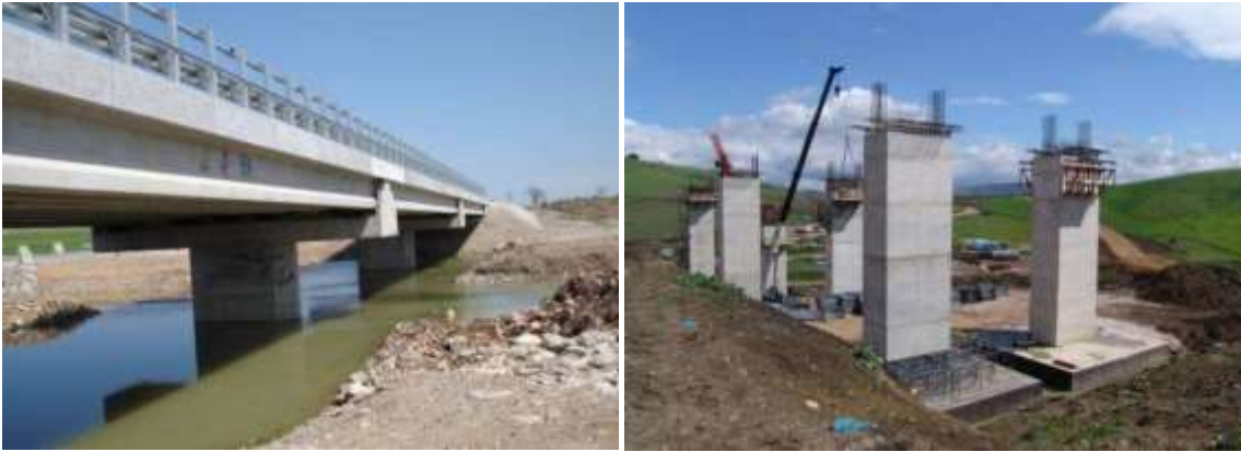
Figure 35 : Achevé et mis en service Avancement des travaux à niveau de l'O.A.
