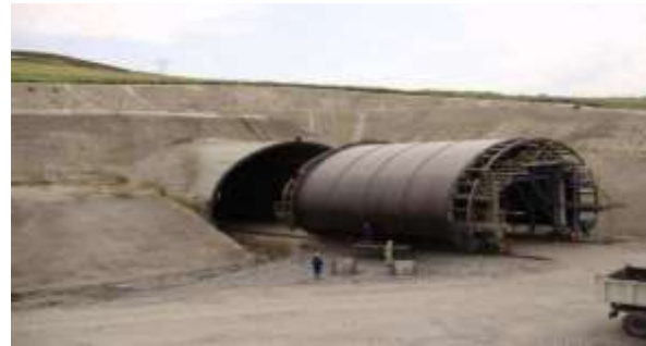
Coffrage au T4 Sud droit
