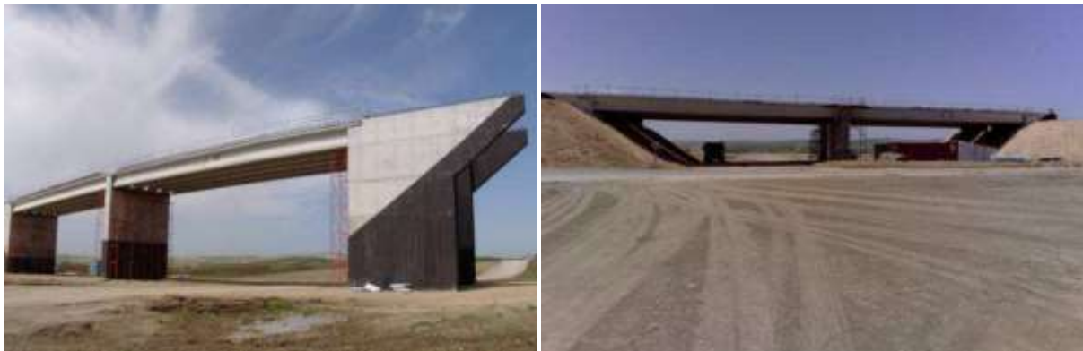
Figure 31 : Exemples des P.S. en phase d'achèvement
