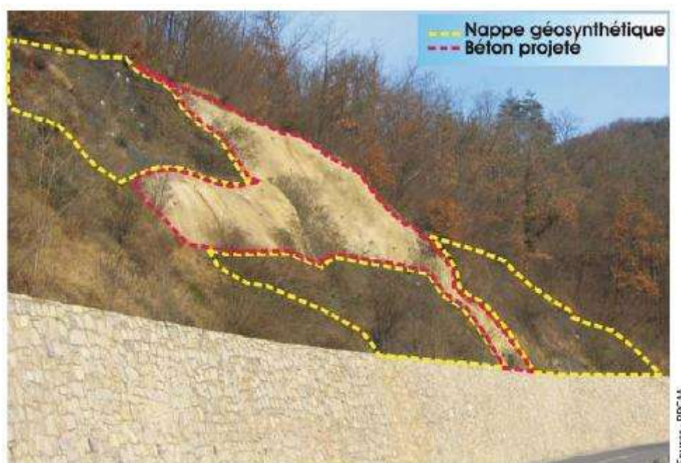
Figure 22 : Nappe en géosynthétique
