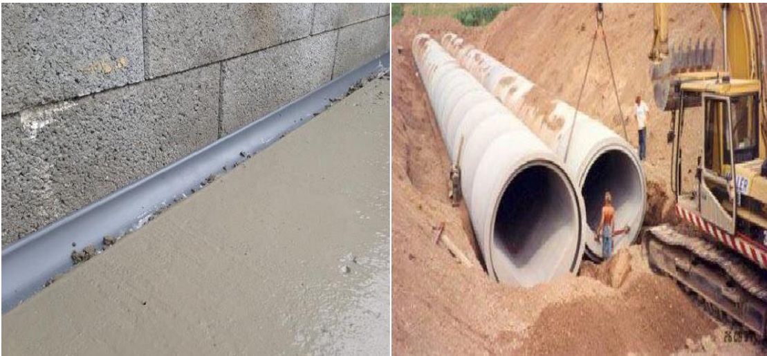
Figure I.2 : Collecte et transport des eaux usées
