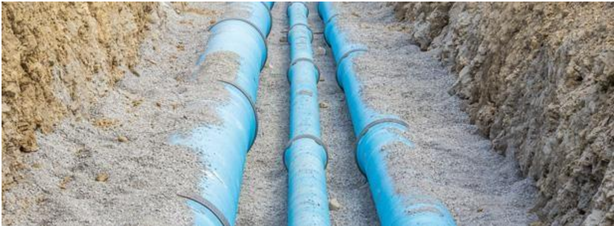
Figure I.1 : Adduction d'eau potable
