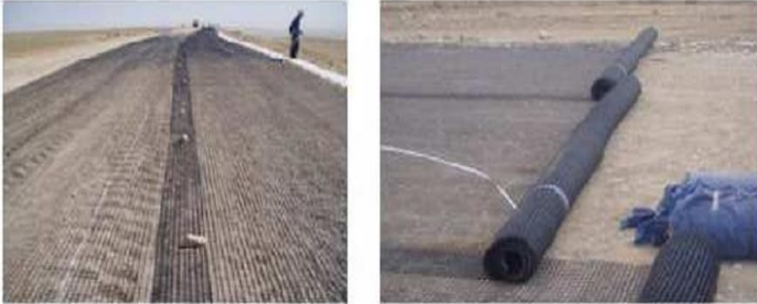
Figure 28: Utilisation du géogrille dans le renforcement
