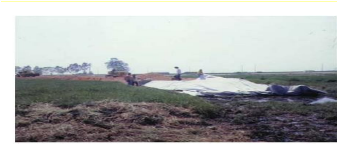
Figure 39: Construction d'une route non revêtue sur une argile organique molle
