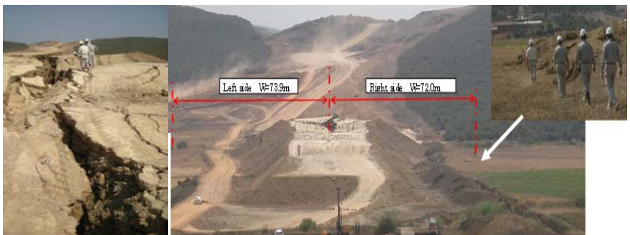
Présentation du type de rupture du remblai en question (remblai du PK384)
