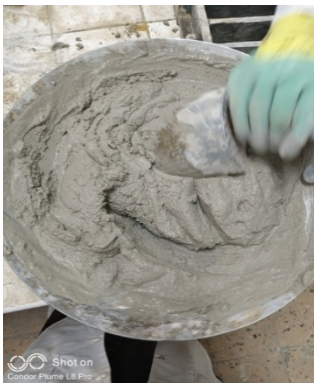
1 er Malaxage du mortier
