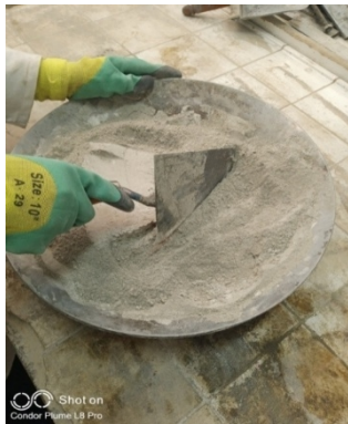
Malaxage à sec du ciment et chaux
