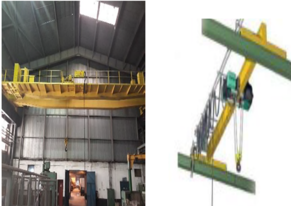
Figure 15: pont roulant posés.
