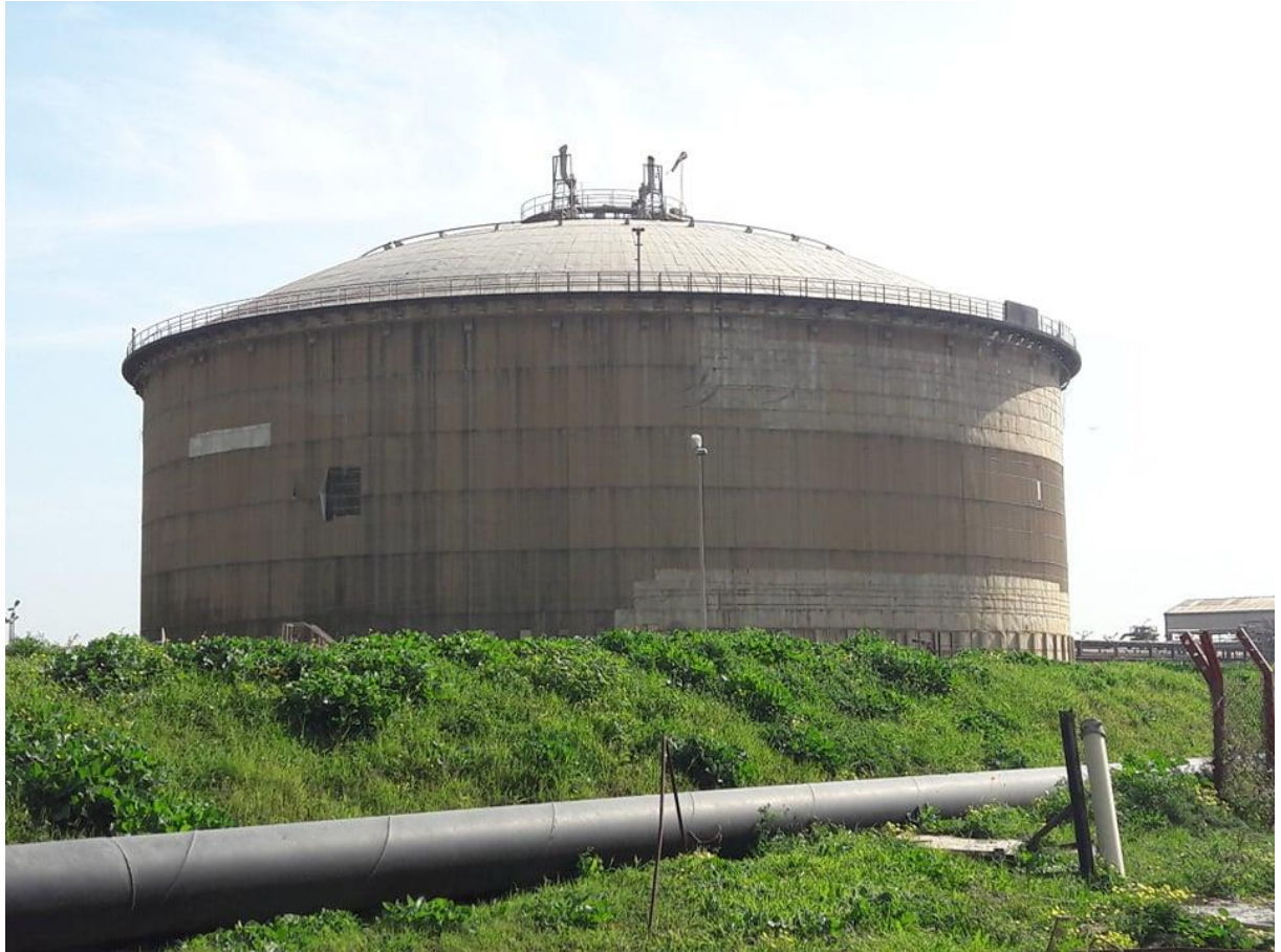
Figure II.II.2 : Photo du bac de stockage d'ammoniac. [18]
