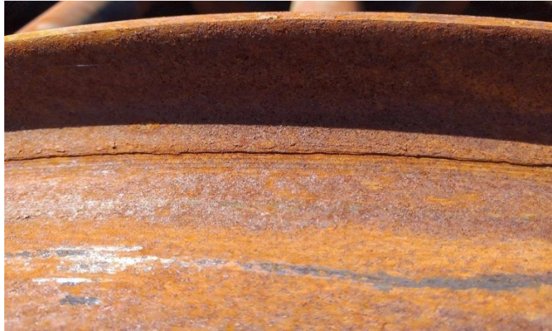
Figure II.6.b : Usure du boudin de la roue ferroviaire.
