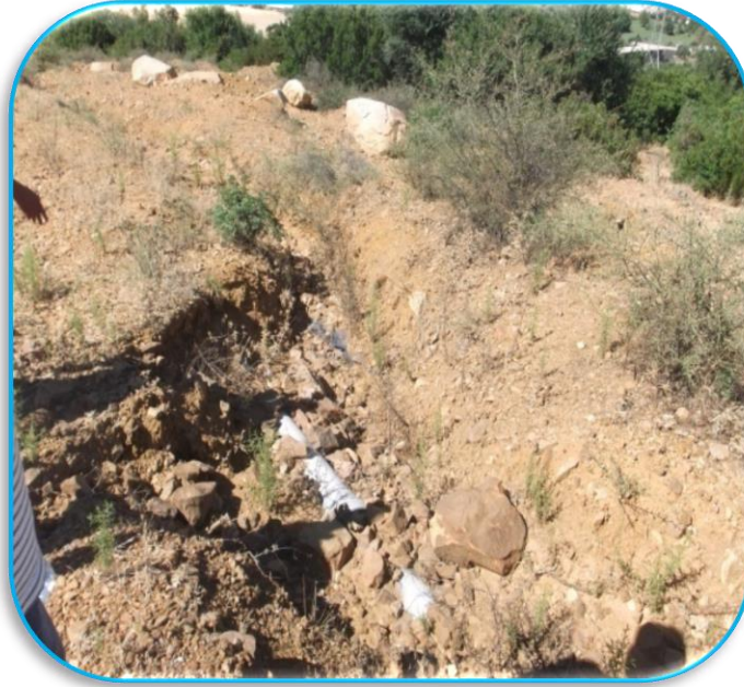
Figure III.6 : Conduite PVC à joint DN250 mm Tronçon de la conduite, déterrée
