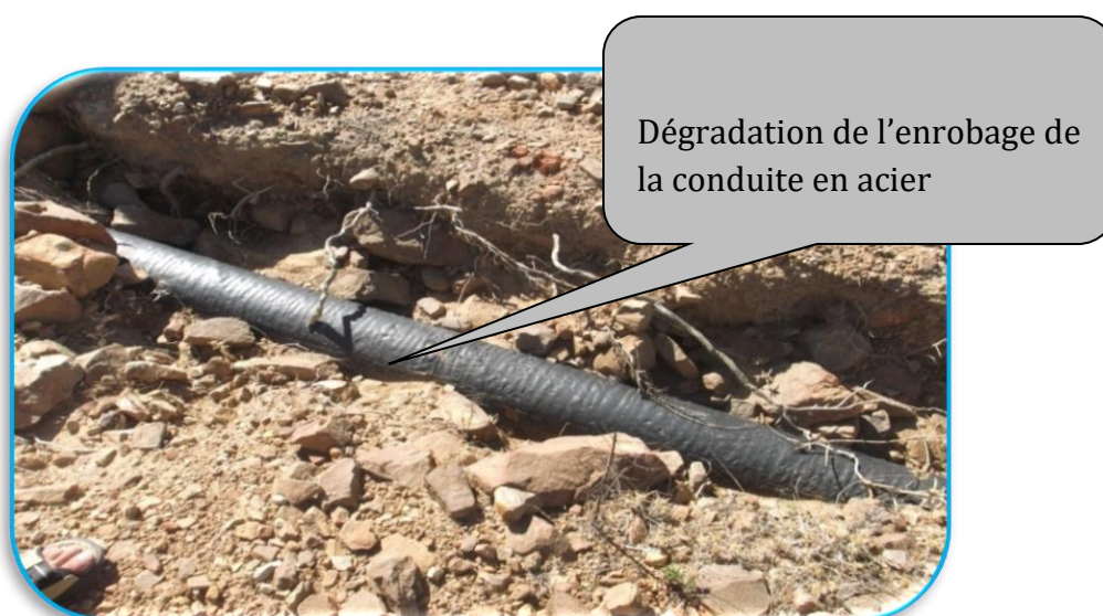
Figure III.4 : Un tronçon de l'autre partie de la conduite de refoulement en acier DN 250 mm, reliant la station de pompage de M'kimen au réservoir 1000 M3 du Lac des Oiseaux, nécessite une intervention en urgence de réfection.
