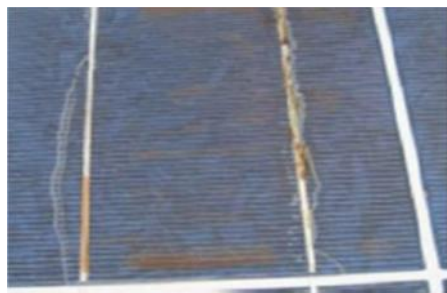
(c) Echauffement de la cellule (face avant)
