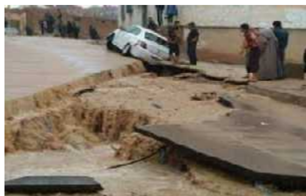
Photo I. 11 : Inondation d'EL Bayadh
