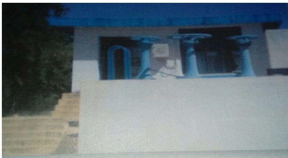
Figure n°14 : Poste de pré chloration «CHAIBA»
