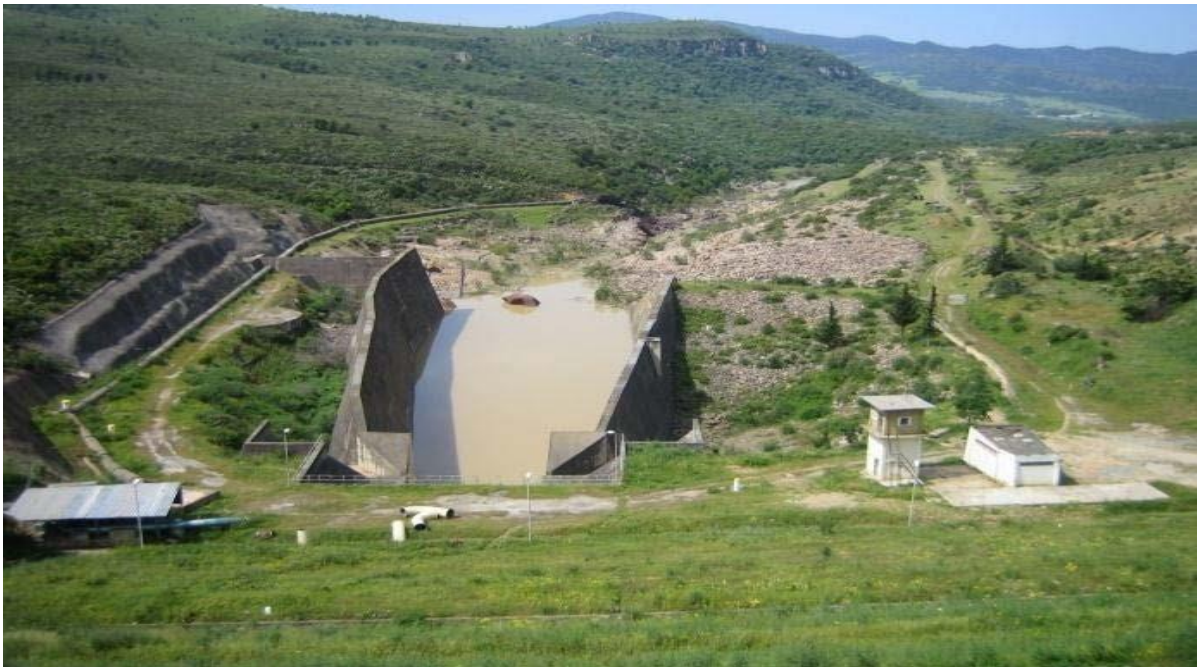
Figure n° 06: Vidange de fond du Barrage Cheffia
