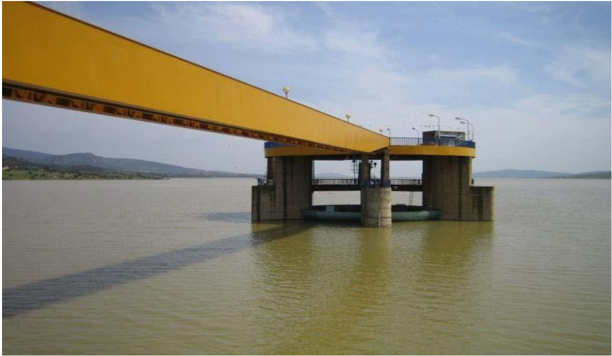
Figure n° 05 : Evacuateur de crues du Barrage Cheffia
