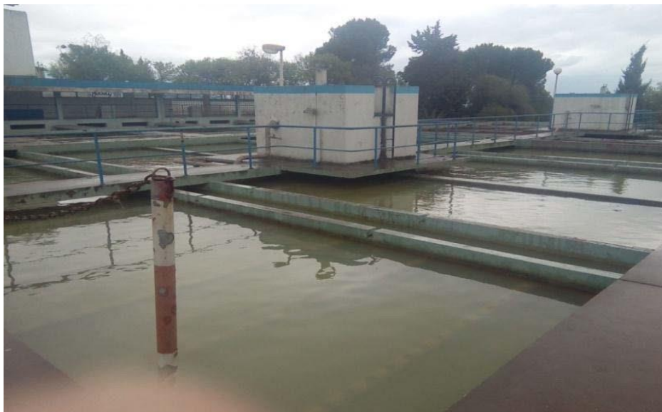
Figure n°15 : Décanteur PULSATOR
