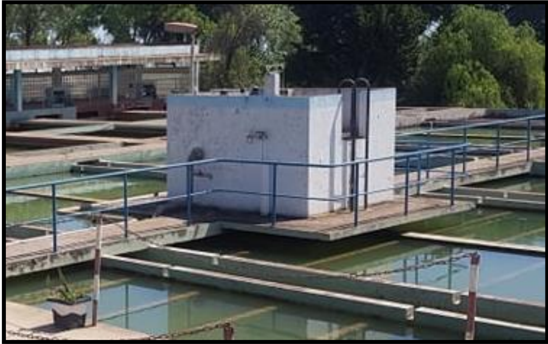
Figure n°13 : Décanteur pulsator « Chaiba »
