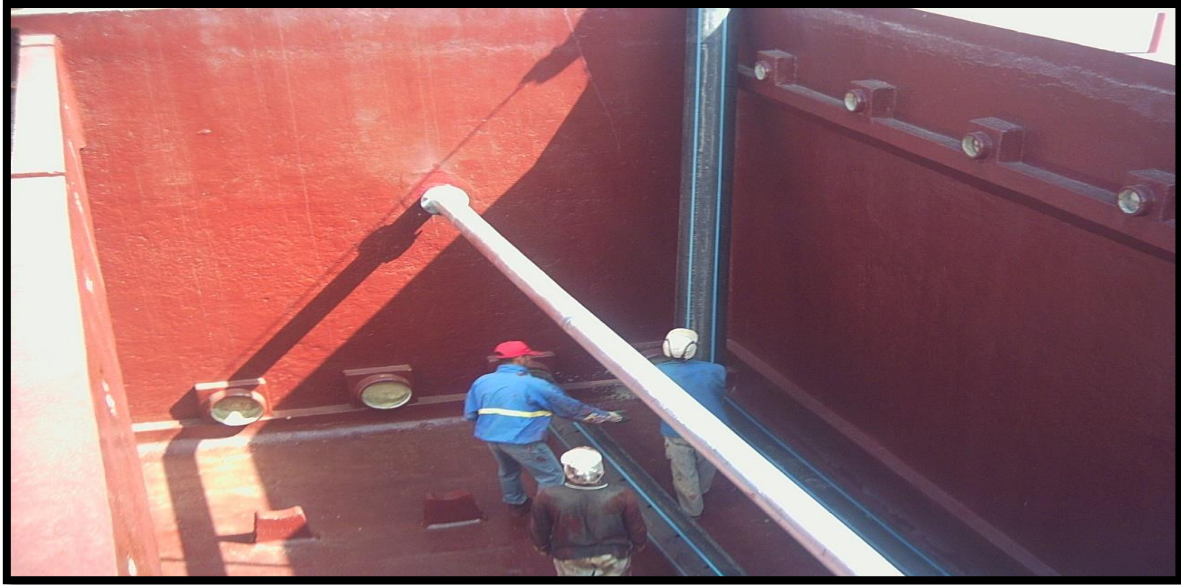
Figure n°21 : installation des ramificateurs inférieures « Chaiba »
