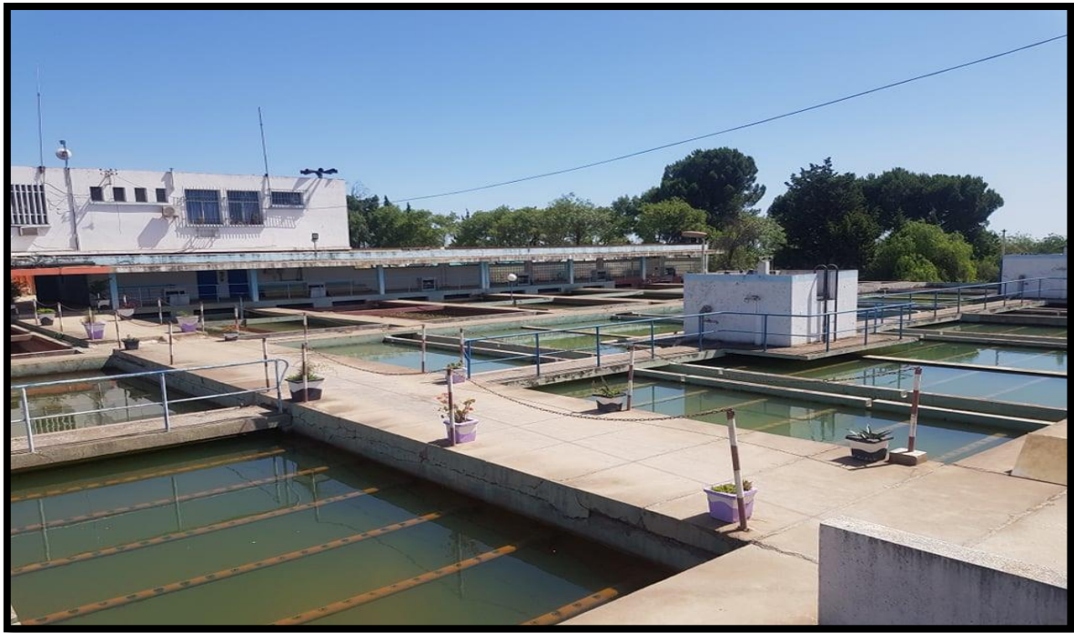
Figure n°18 : la station de traitement des eaux « Chaiba »
