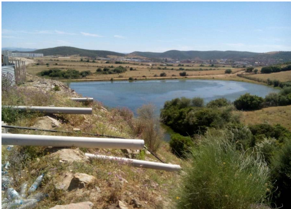
Figure II.8 : Rejets d'eaux usées dans la retenue source : Urbain.
