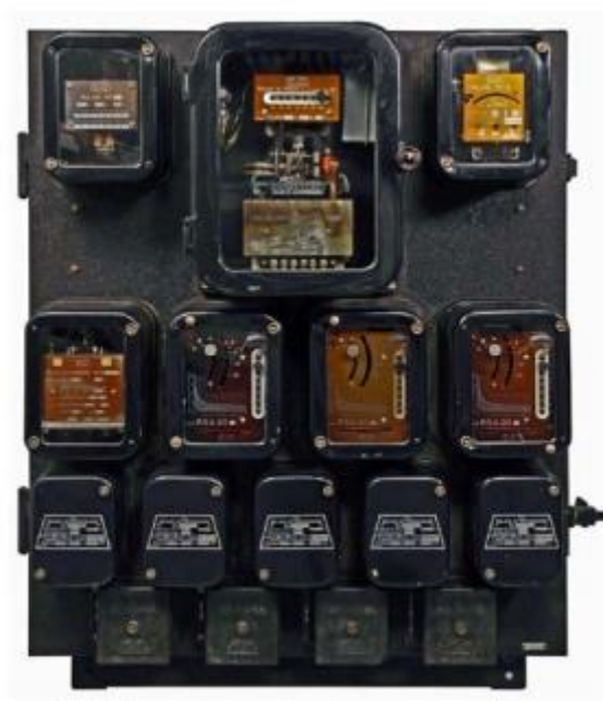
Figure IV : 6 relais électromécaniques marquent CDC type PSAD-1957
