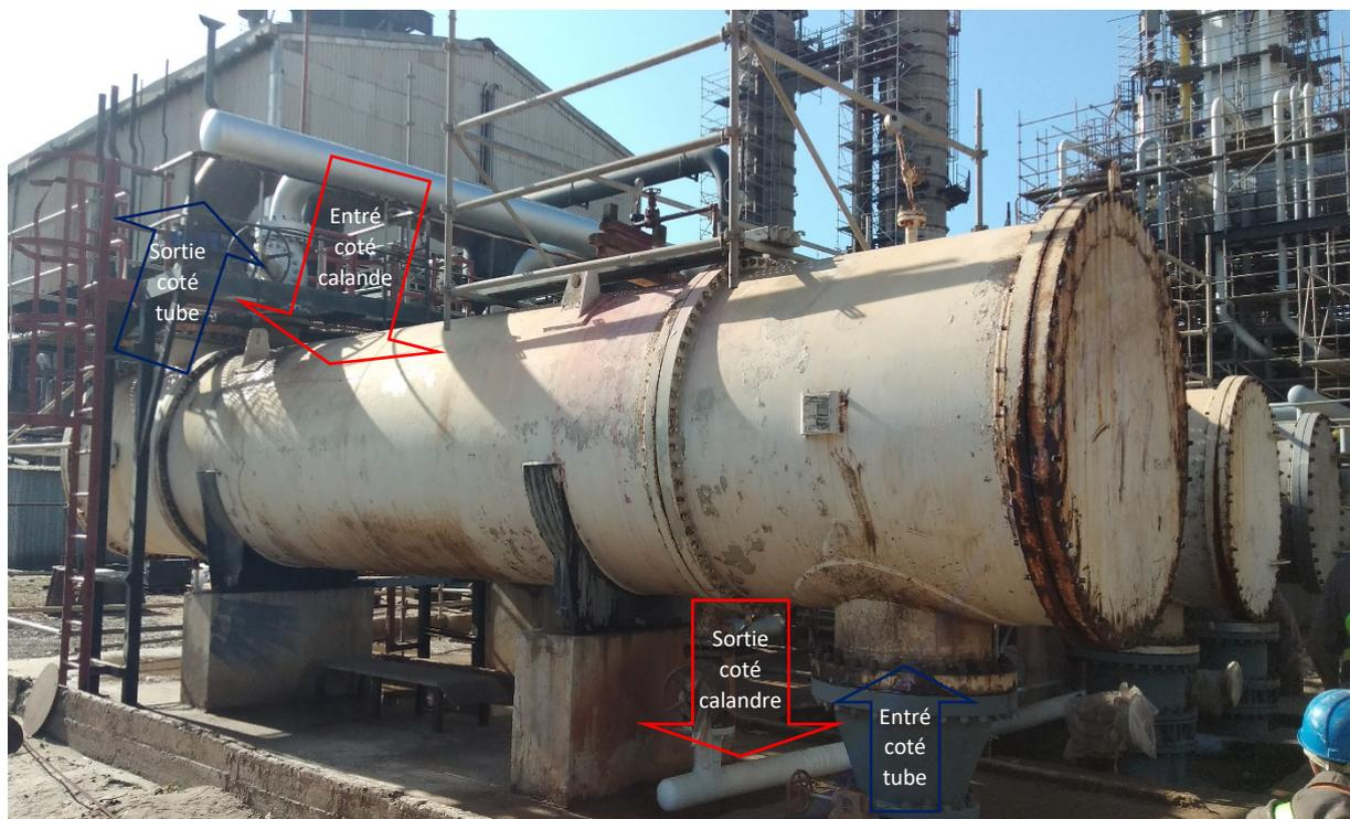
Figure II.4 : Entré et sortie de l'échangeur
