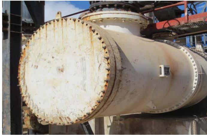
**Figure II.11** : Boite de distribution image réelle
