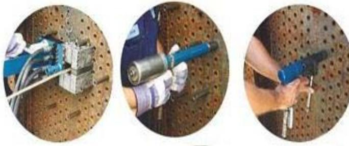
Figure II.14: nettoyage des tubes.
