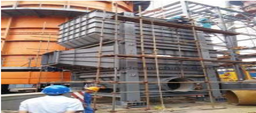
**Figure I. 22:** Echangeur à Bloc
