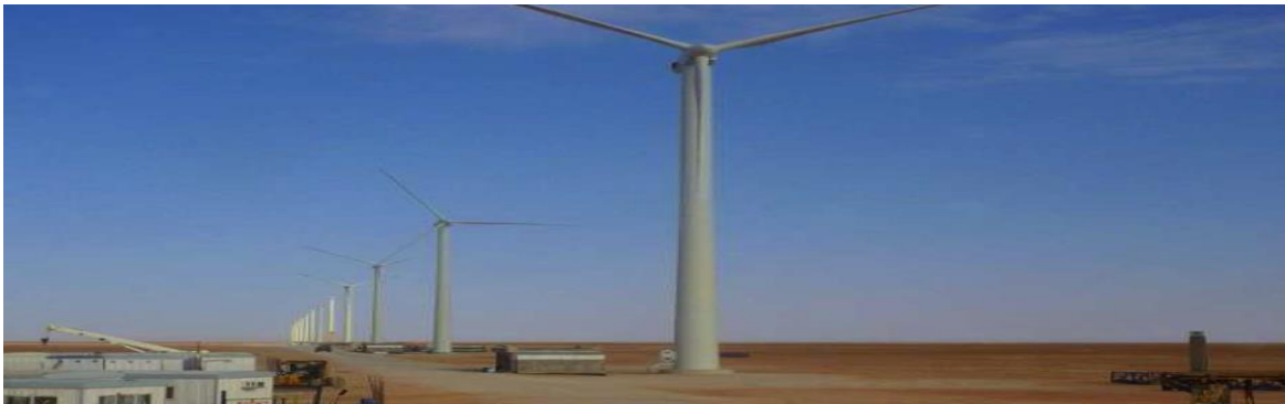
Figure I.17 La ferme éolienne d'Adrar
