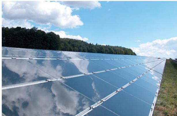
Fig. 2. 6. Modules verre-verre au Telluride de Cadmium, efficacité de 9 à 11%
