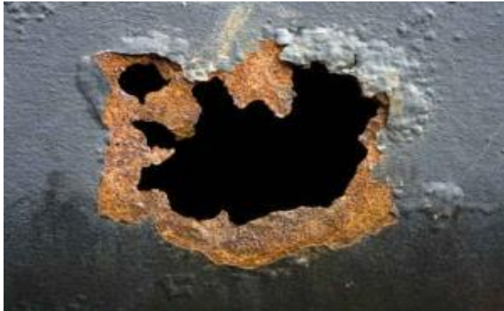
Figure 1-6 : corrosion par piqures d'un tuyaux de fer. [31]
