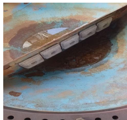
figure 3-10 : photo réel des anodes sacrificiels
