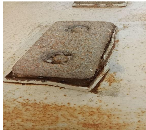
Figure 3-8 : une anode sacrificiel(en Zn)
