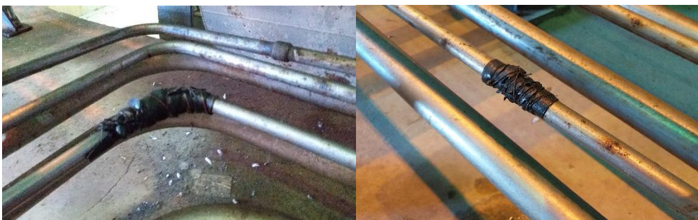
Figure 19 : Réparation temporaire d'un trou afin de ne pas causer un arrêt de travail de l'unité.
