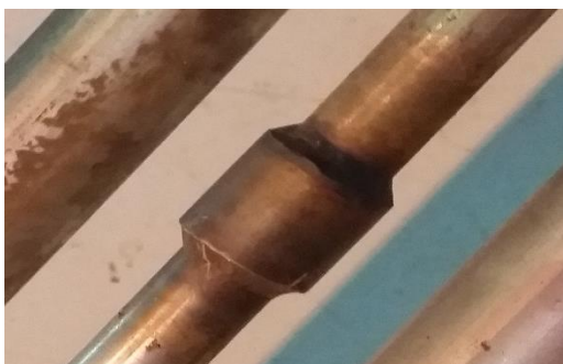
Figure16 : Soudure de nouvelle partie des tubes
