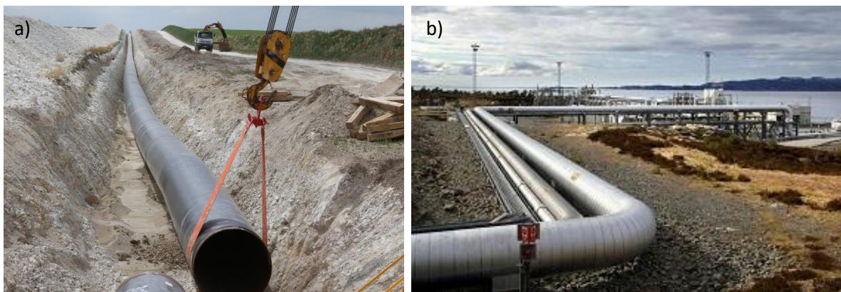
Figure.1 Installation des pipelines a) enterrés b) externes
