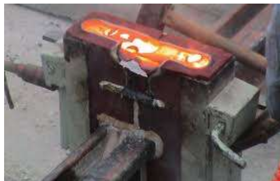
Figure II.12: Vue d'une soudure aluminothermique de rail
