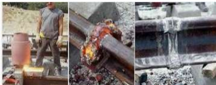
Figure II.16 : Réalisation de la soudure aluminothermique
