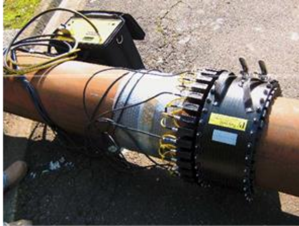
Figure-II.3 : Photographie des palpeurs de LRUT installés sur tube
