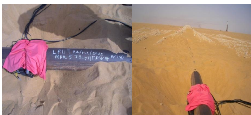
Figure- IV.17 : Vue de l'emplacement du test LRUT (point 2).
