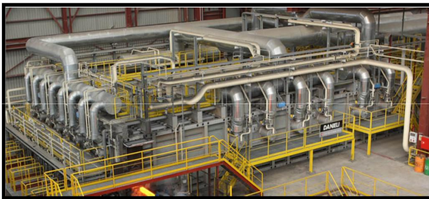
Figure III.7 : Four de réchauffage des billettes.
