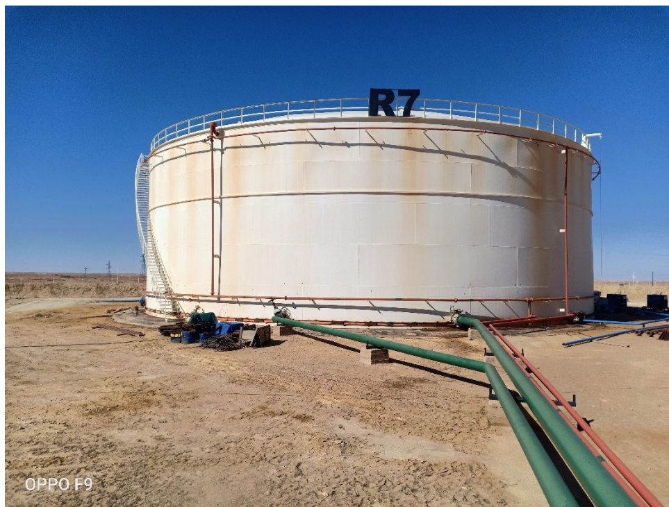
Figure 30 Bac de stockage de brut dans La région TFT-Illizi Sonatrach
