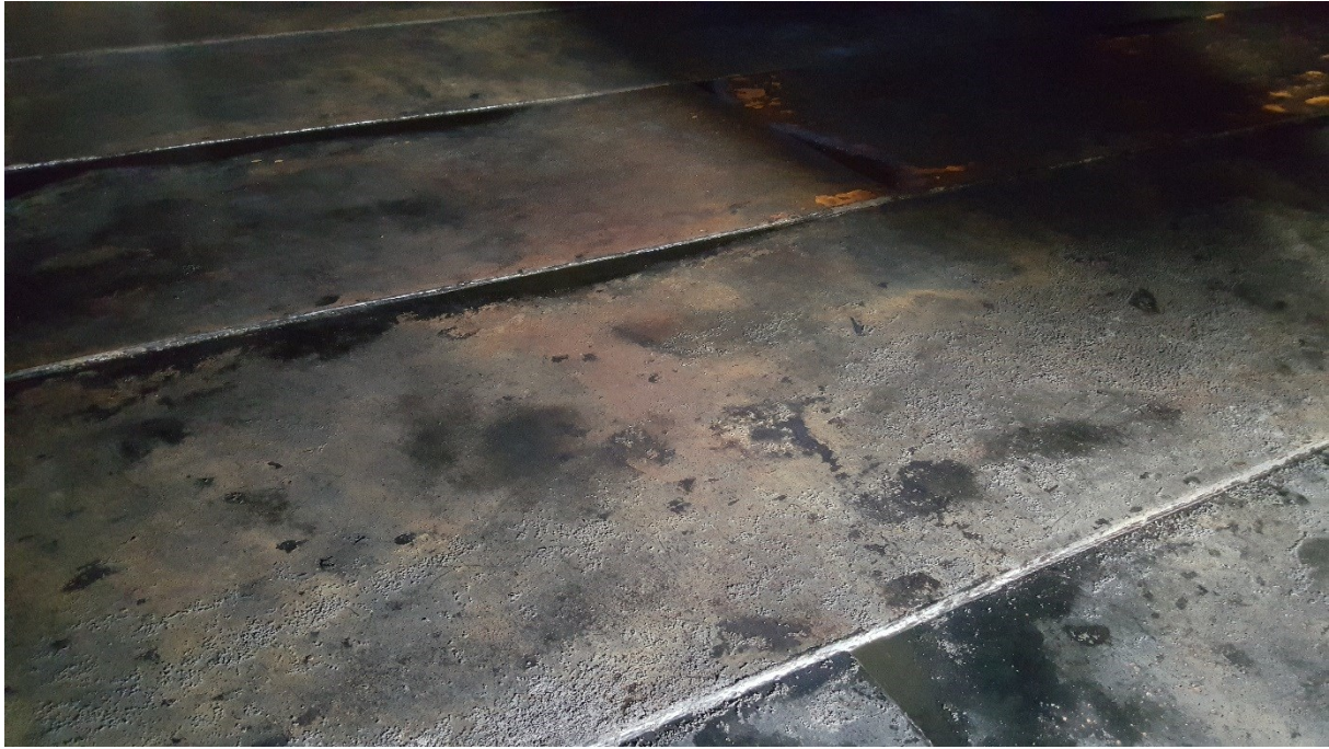
Figure 64 Les tôles de fond R8 avant la réparation
