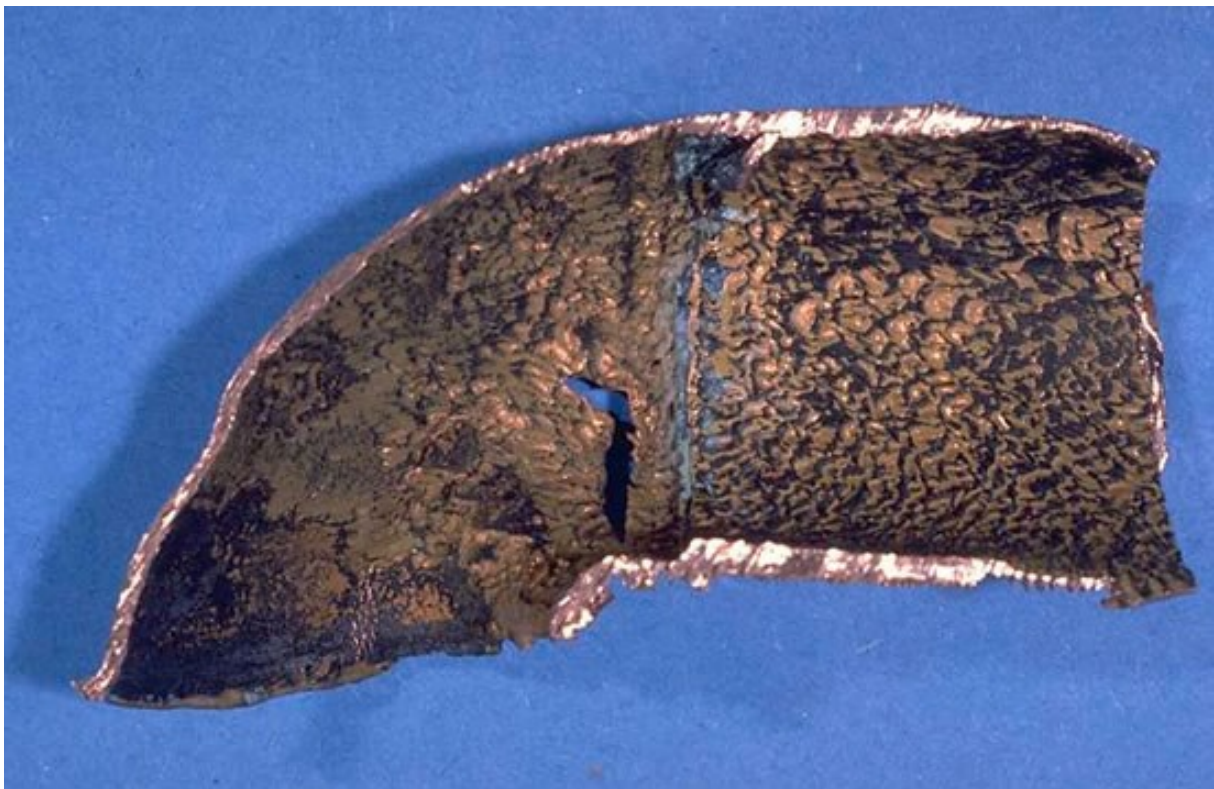
Figure 11 Corrosion-érosion d'un tube en cuivre véhiculant de l'eau [3]
