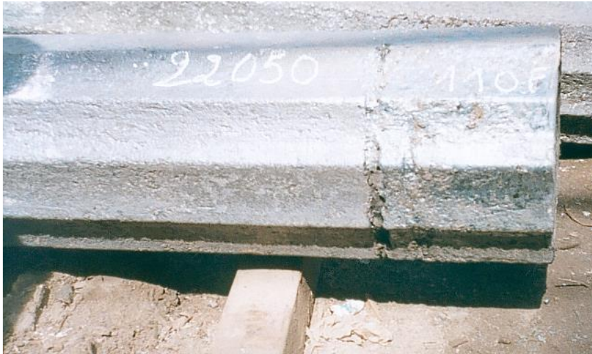
Figure 34 : Reprise de coulée
