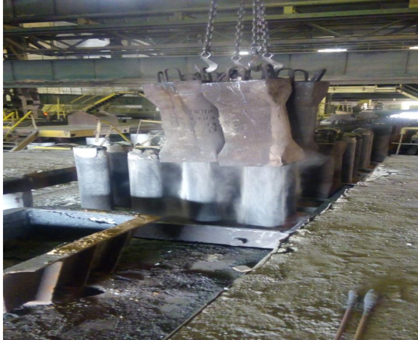
Figure 31: Opération de démoulage
