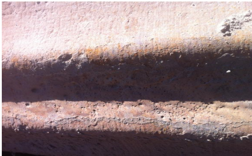
Figure 33 : Soufflures – Piqûres
