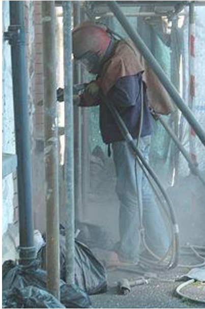
Figure. I.13 : Ravalement de façade à l'aide de sable à haute pression
