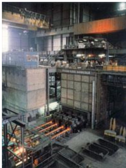
Figure I.3 : Une installation de coulée continue produisant des billettes. [25]
