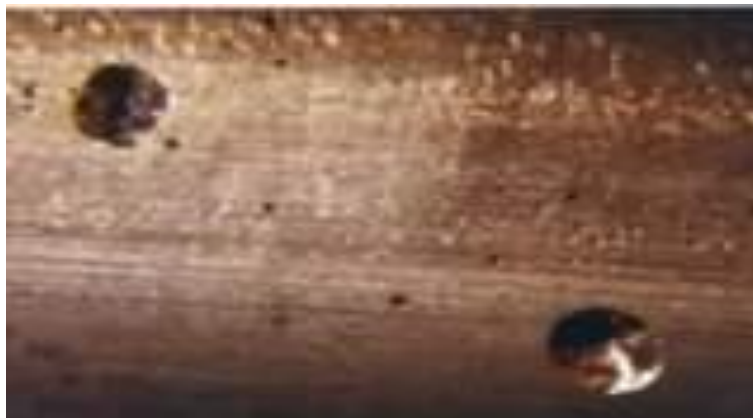
Figure IV.5 :Corrosion par piqûres d'un acier inoxydable
