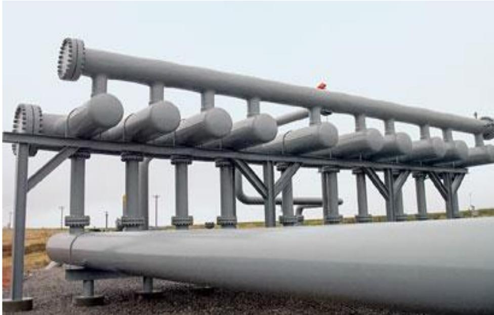
**Figure -4** système de Slug Catcher
