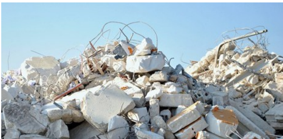
Figure I-3 Photos des déchets de démolition
