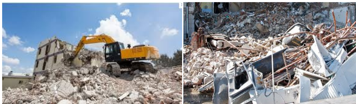
Figure I-2 Photos des déchets de démolition
