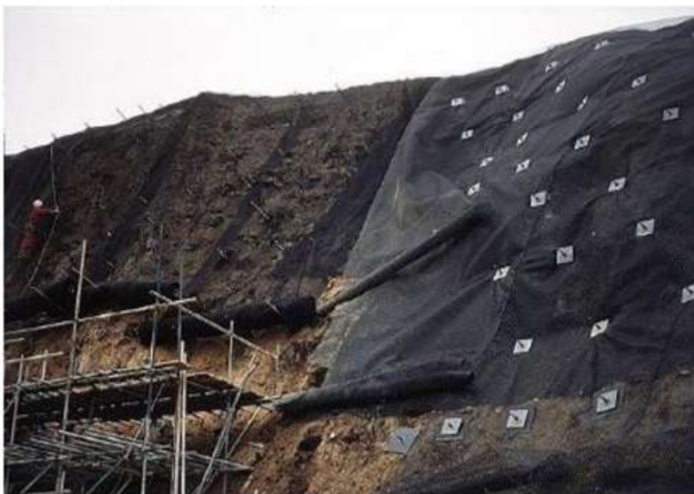
Figure IV.16 : : Un versant stabilisé par clouage.
