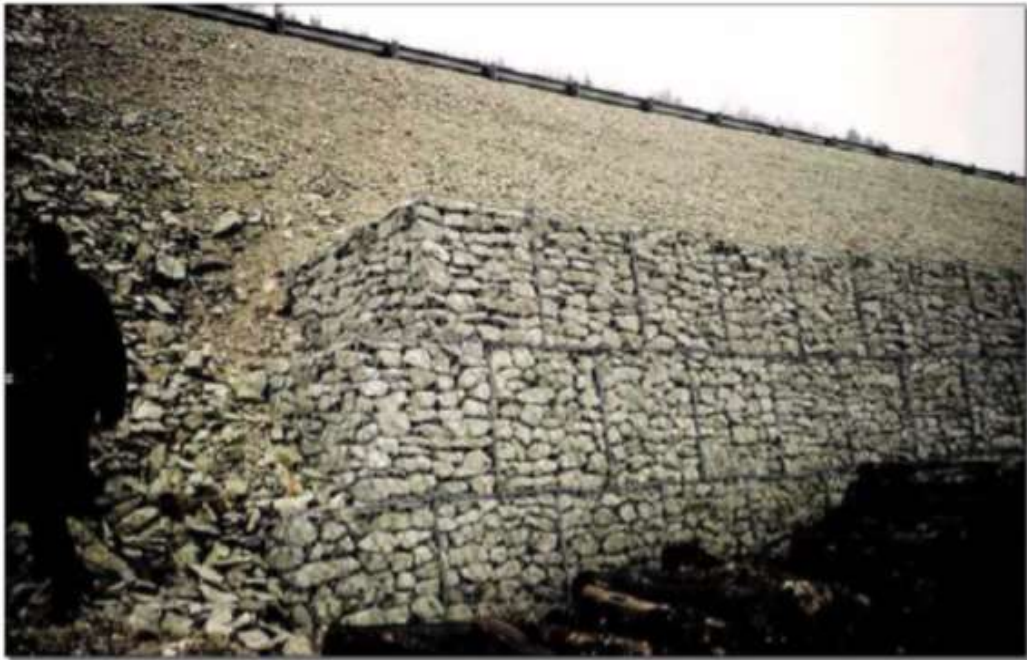
Figure IV.14 : Exemple d'ouvrage souple : Mur en gabion (Service d'Etude Technique des Routes et Autoroutes (SETRA)).
