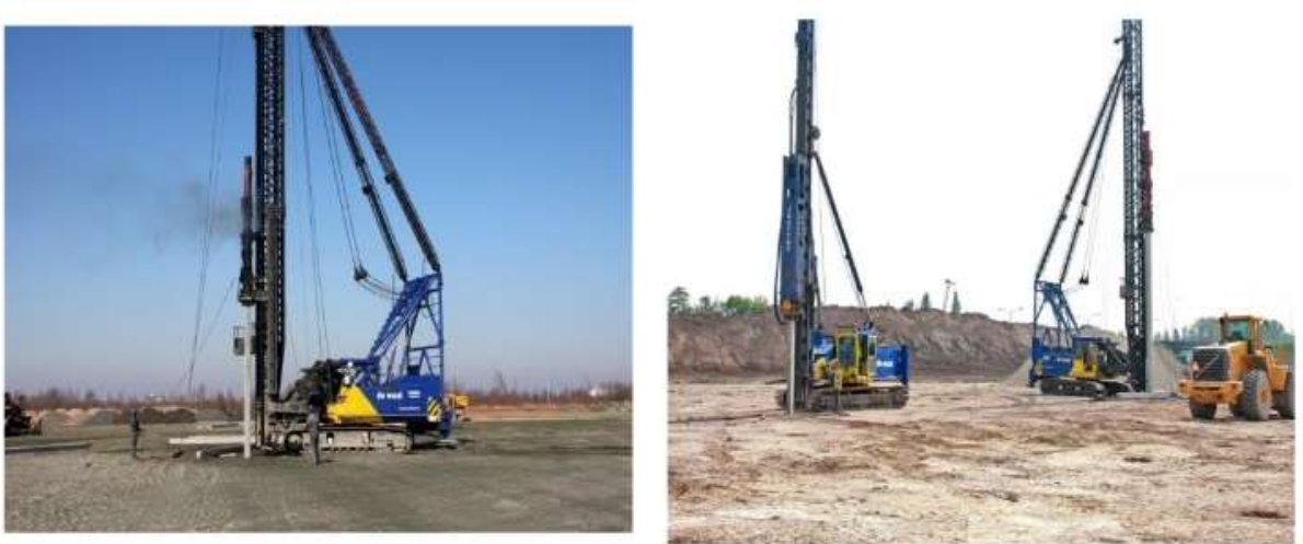
Figure IV.17 : Photos pendant la réalisation de pieux battus.
