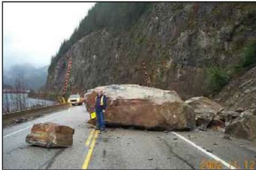
Figure I.9 : Chute de pierres et blocs.
