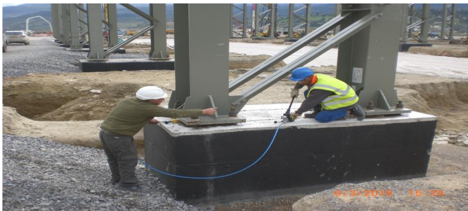
Figure II.2. Fondations en béton armé
