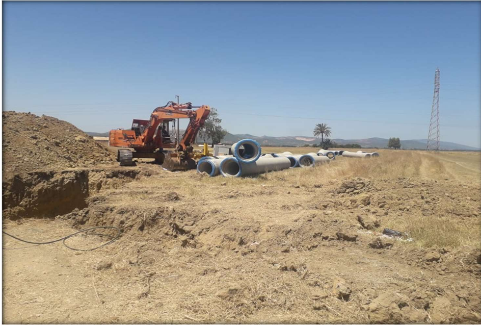
Figure 38-Stockage des tuyaux près de la tranché
