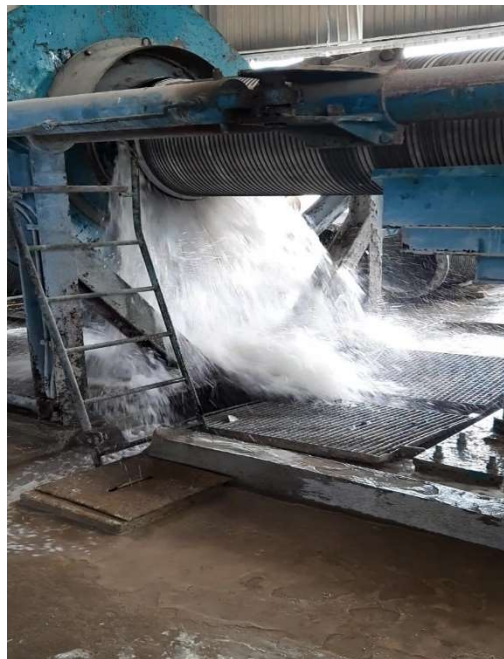
Figure 34-purge après essai hydrostatique
