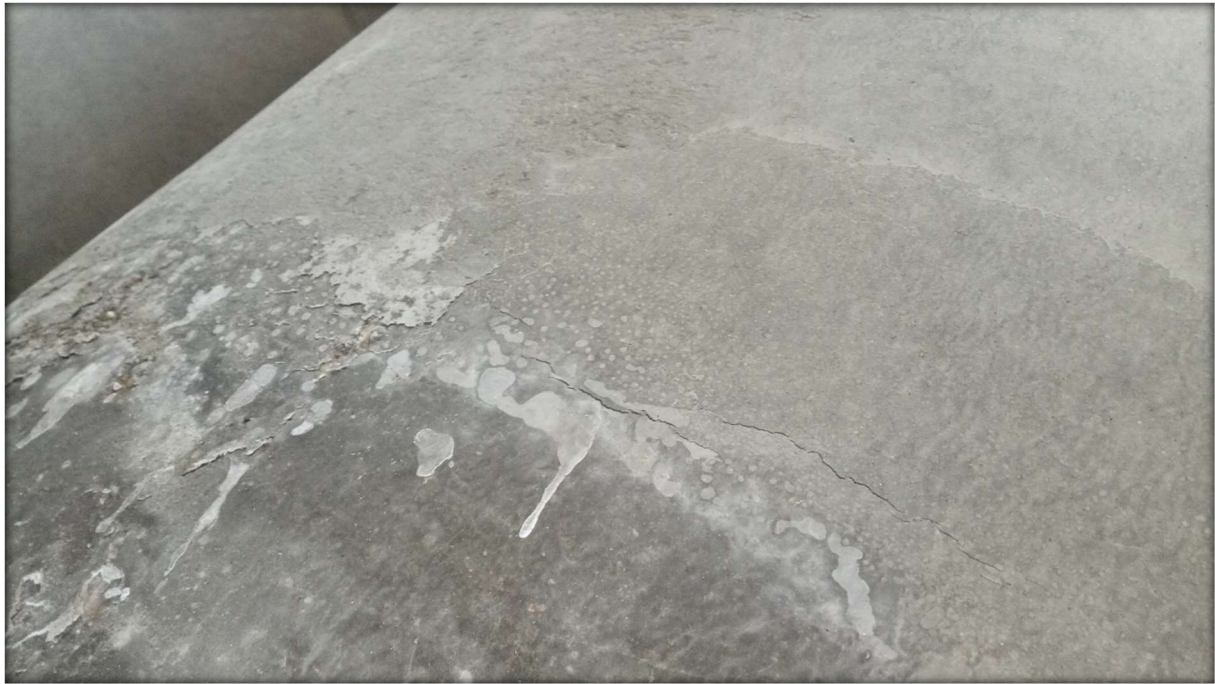
Figure 16-résultats d'un traitement thermique a température trop élevées
