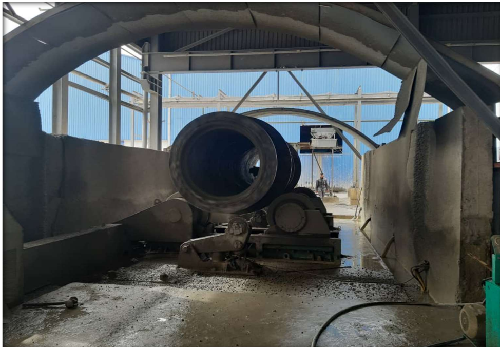
Figure 26-Tuyaux en phase de centrifugation
