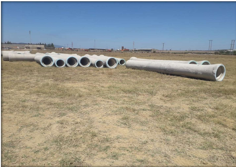
Figure 37-Stockage des tuyaux au site de la pose
