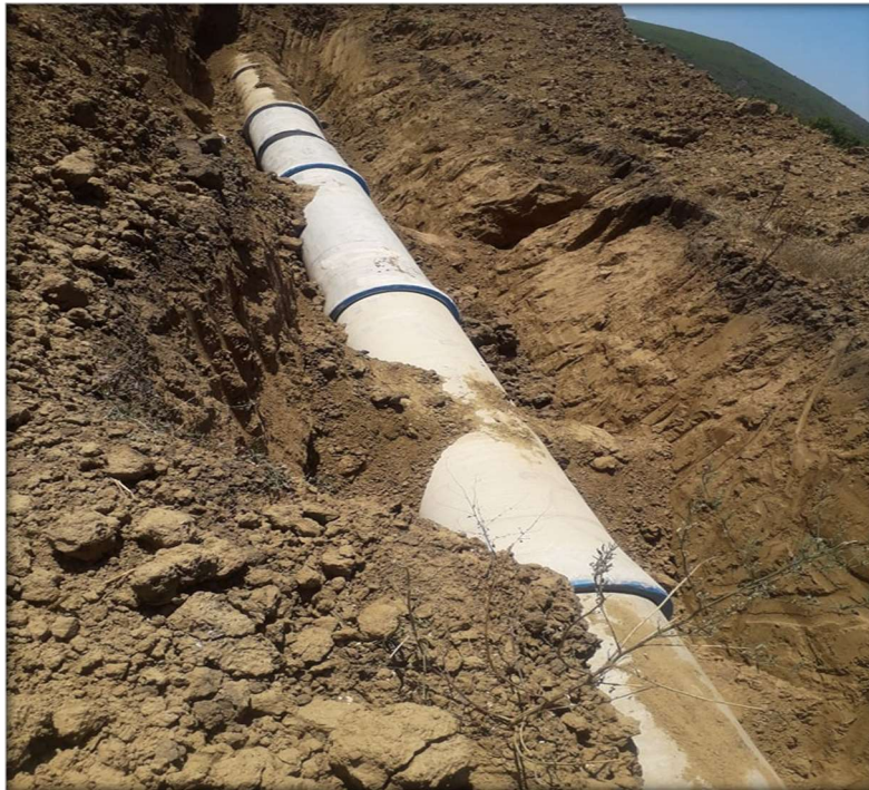
Figure 40-Emboitement de deux tuyaux
