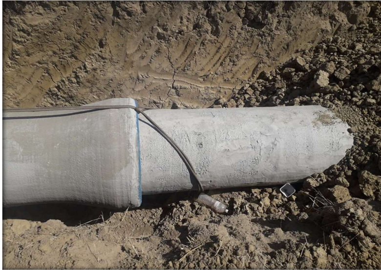
Figure 40-Emboitement de deux tuyaux
