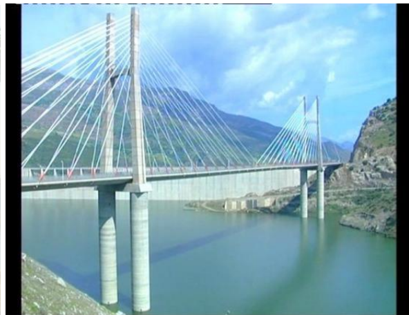
Figure I.14. Le pont de Mila
