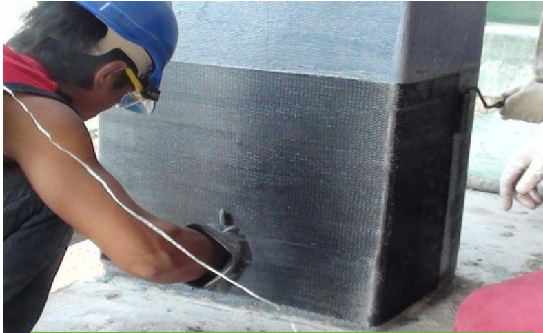
Figure 9 : Chemisage en fibre d'un poteau
