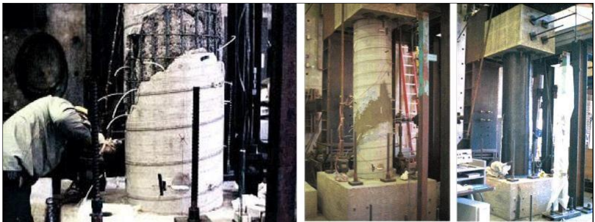
Figure 6 : Traitement et renforcement par PRFC
