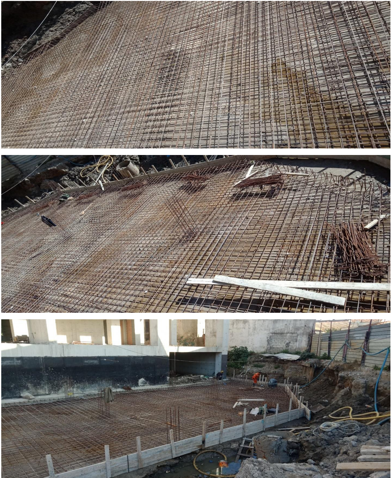
Figure I-14: Ferrailage final du radier dalle après mise en place de la nappe sup et inf et des attentes des poteaux
