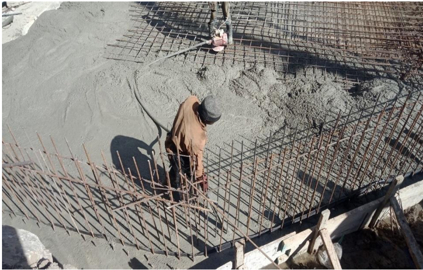
Figure I-20: Vibration du béton
