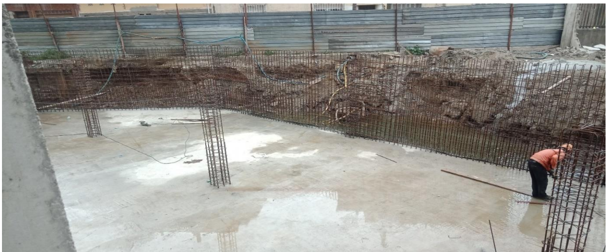
Figure I-17: Ferrailage des poteaux et voile périphérique
