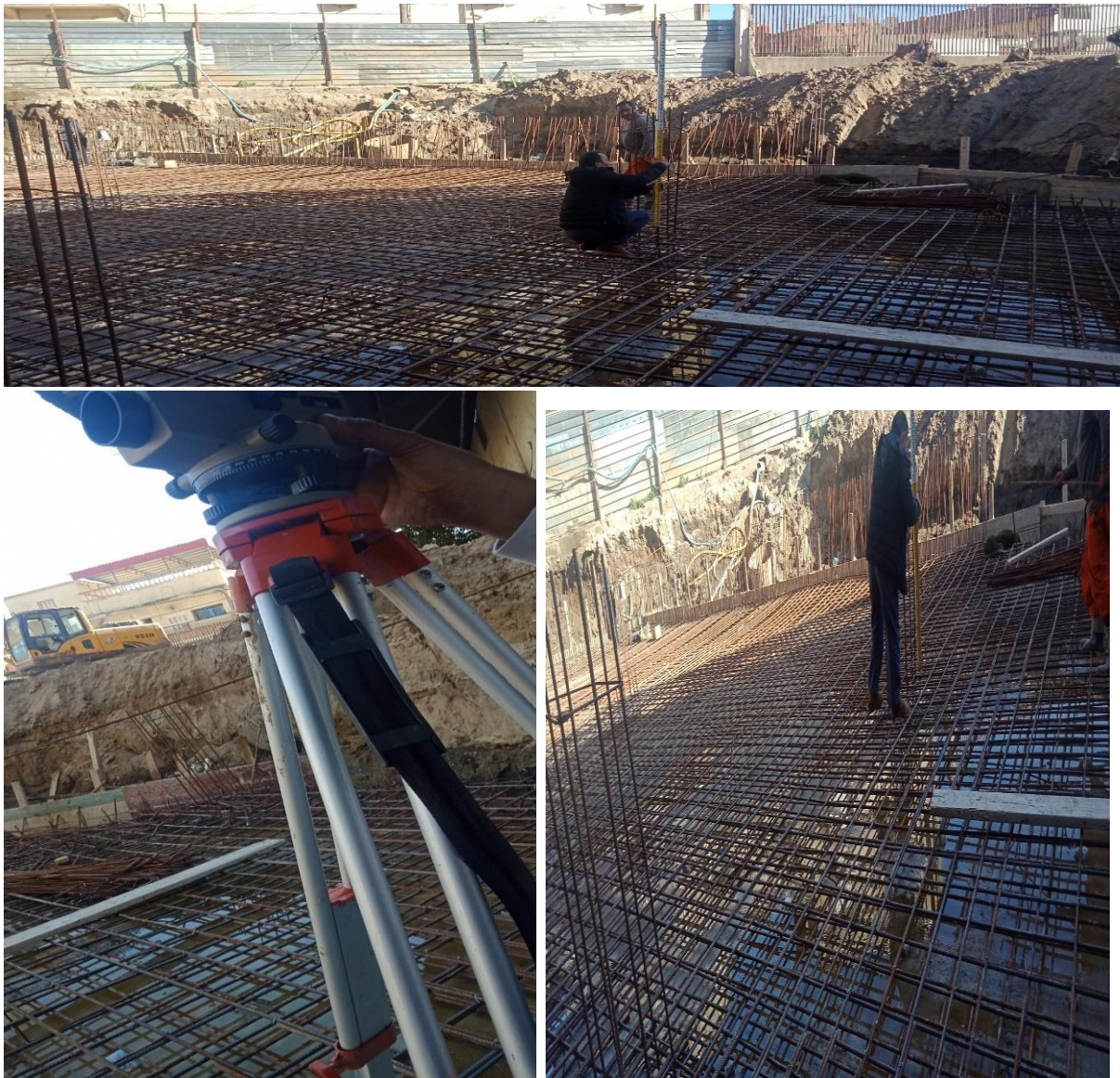
Figure I-15: Vérification du niveau du radier dalle à l'aide d'un appareil optique sur trépied
