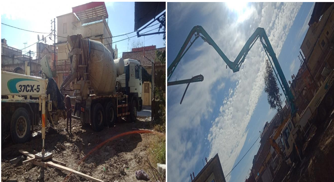
Figure I-19: Réception du béton et mise en place à l'aide d'une pompe girafe
