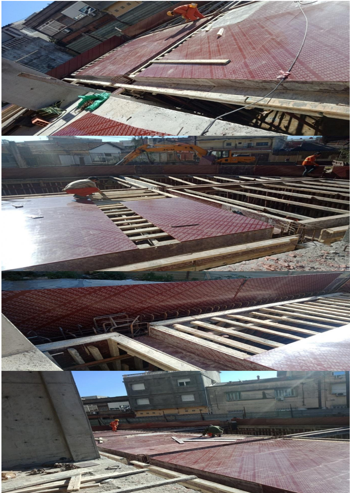
Figure I-12: Coffrage lors de l'exécution (platelage et lisses en bois)
