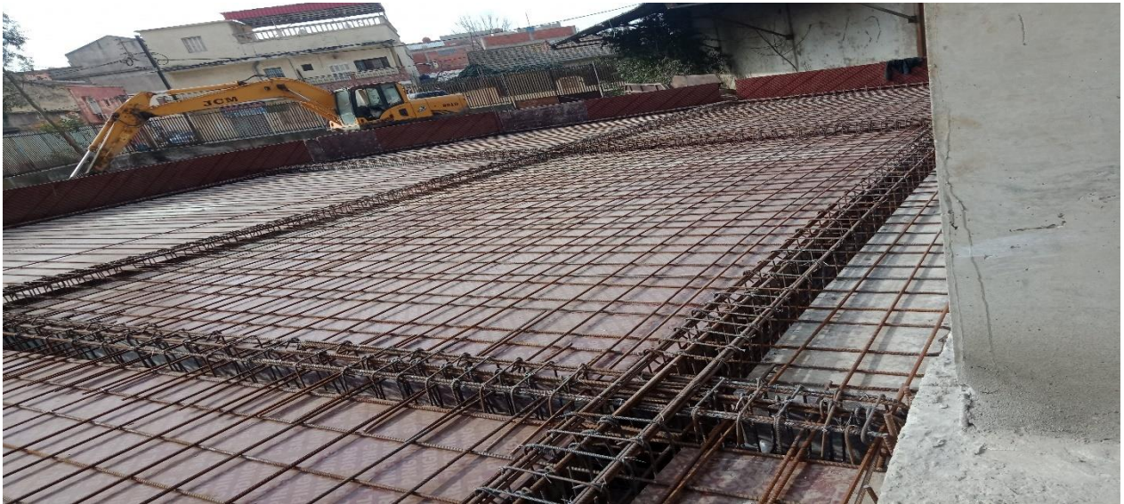
Figure I-16: Ferrailage des poutres et la nappe inférieure e_p=18\text{cm}
